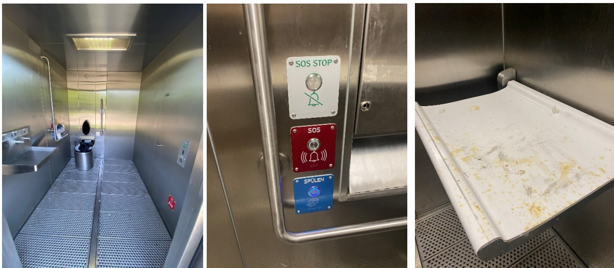
Abbildung 23, 24 & 25 Barrierefreies WC, Notrufschialter und Wickeltisch. Quelle: Eigene Aufnahmen, 2025.
