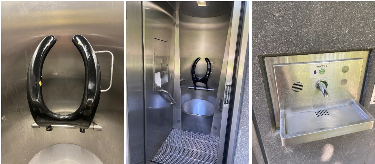
Abbildung 20, 21 & 22 Ausstattungselemente: Sitz, Edelstahlschüssel und außen angebrachtes Handwaschbecken. Quelle: Eigene Aufnahmen, 2025.
