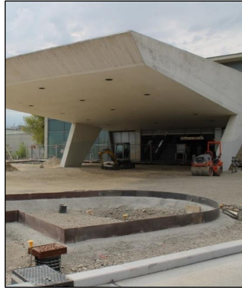
Abbildung 24: Bahnhof Aspern Nord mit (künftigen) Vorplatz (Michael Kloiber, 2025)
