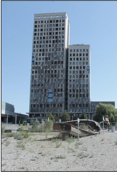
Abbildung 20: Holzhochhaus HoHo im Seeparkquartier (Michael Kloiber, 2025)
