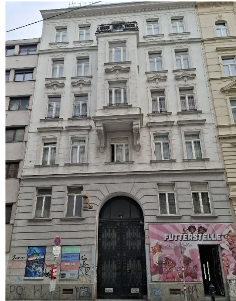
Abbildung 73: Quaderputz – Beispiel Quelle: Eigene Aufnahme, 17.02.2025
