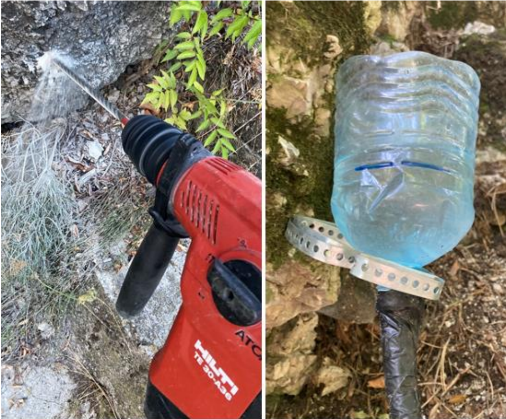
Abbildung 17: Der Bohrhammer Typ „Hilti TE 30-A36“ während einer Versuchsbohrung (links) und die Halterung mit dem Flüssigkeitstrichter (rechts).
