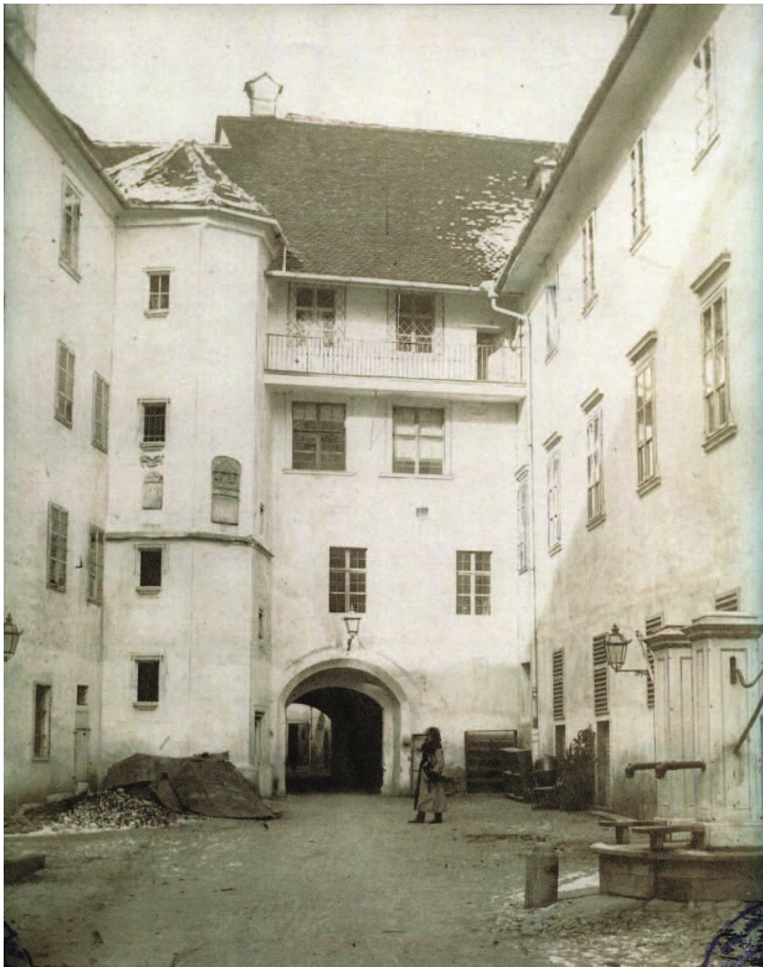
Abb. 79 Johann Bosch, Ansicht des ersten Burghofes mit Südfassade des Maximilianstrakts und Turm der Doppelwendeltreppe, Fotografie, vor 1854, Graz Museum.
