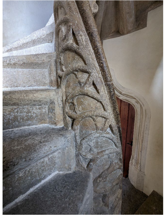
Abb. 33 Treppenwange der Hohlspindel mit Maßwerk und Handlauf, rechts.
