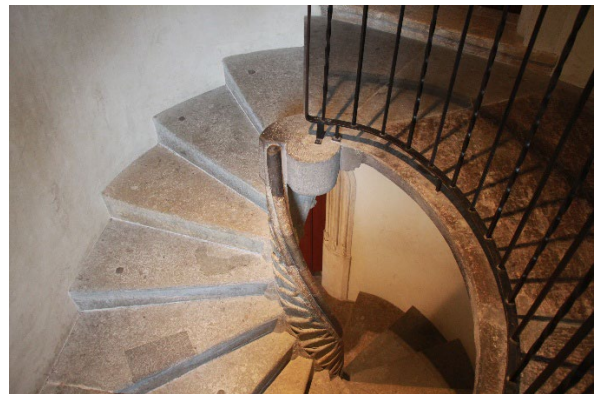
Abb. 26 Abschluss des rechten Treppenlaufs im dritten Stockwerk.
