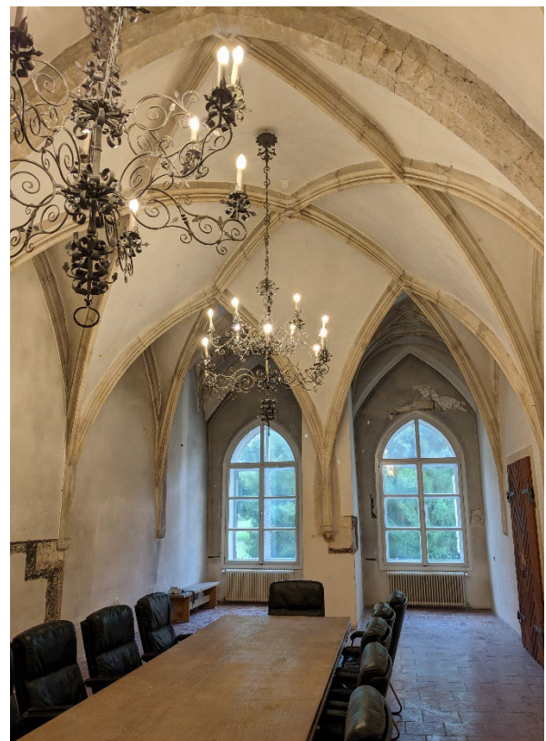
Abb. 15 Heutiger Zustand der Kammerkapelle im ersten Stockwerk.
