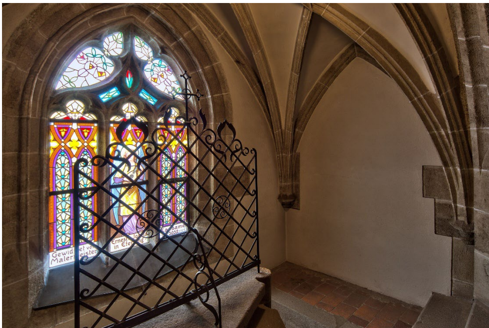
Abb. 45 Oberer Abschluss der Zwillingswendeltreppe in Eferding, um 1505.
