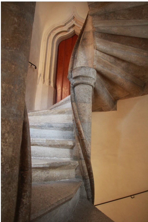
Abb. 22 Übergang der massiven Spindel zur Hohlspindel mit Kapitellabschluss unterhalb des Portals des ersten Stockwerks.
