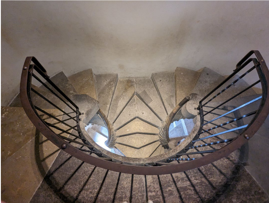
Abb. 24 Ansicht des abschließenden Podests im dritten Stockwerk, Blick von oben.
