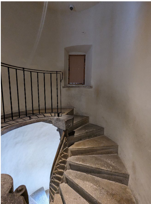
Abb. 25 Abschluss des linken Treppenlaufs im dritten Stockwerk.
