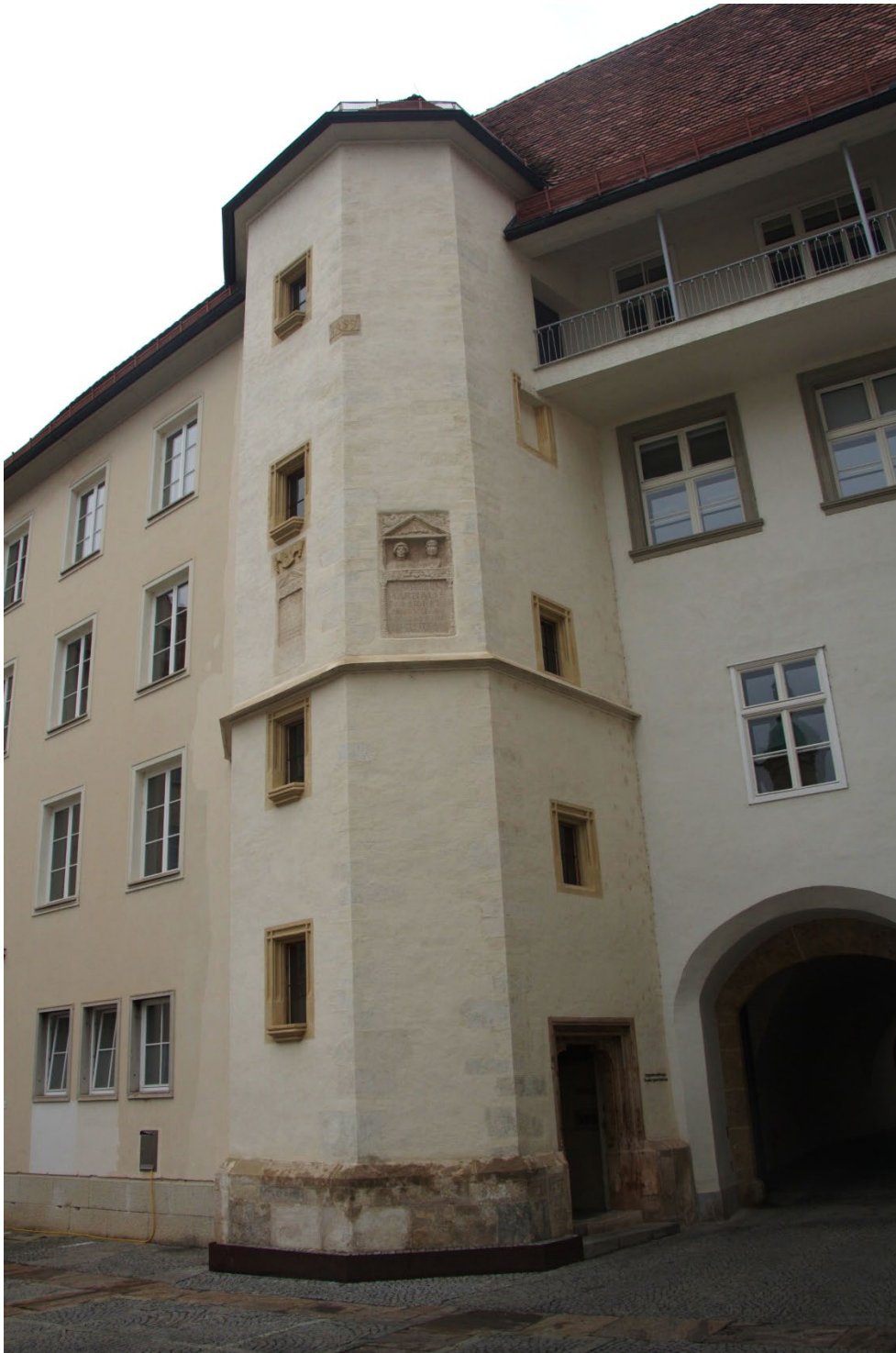
Abb. 20 Heutige Ansicht des Turmes der Doppelwendeltreppe.
