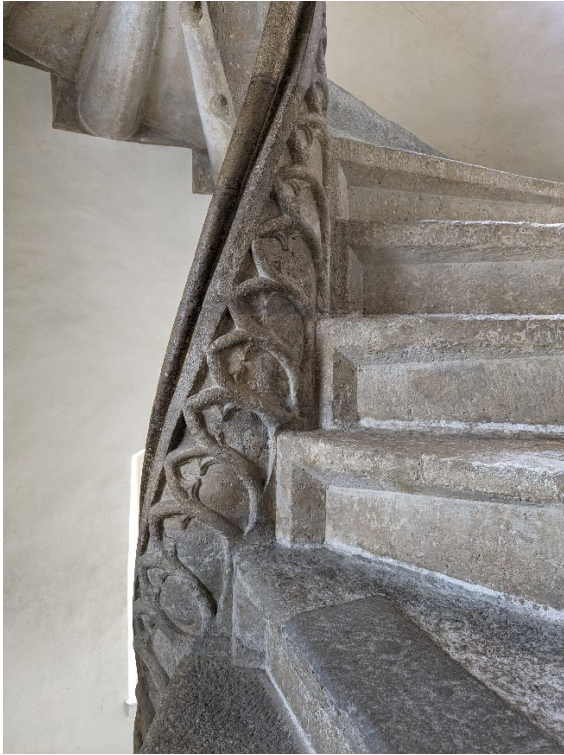
Abb. 32 Treppenwange der Hohlspindel mit Maßwerk und Handlauf, links.
