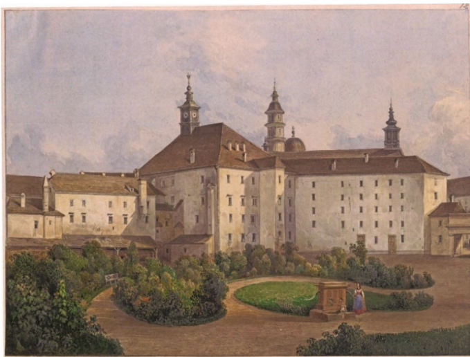
Abb. 66 Joseph Kuwasseg, Ansicht der Rückseite der Burggebäude mit Friedrichstrakt und Ferdinandstrakt vor der Schleifung, Aquarell, vor 1854, Österreichische Nationalbibliothek.
