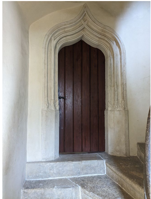
Abb. 30 Zugangportal in das zweite Stockwerk des Maximilianstrakts.
