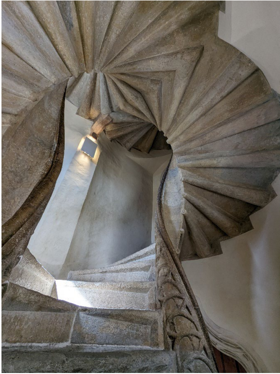
Abb. 21 Innenansicht der Doppelwendeltreppe.
