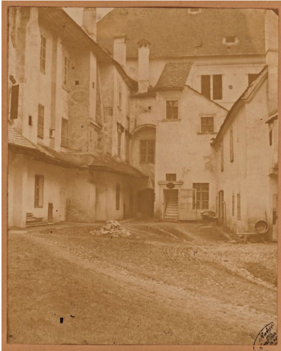
Abb. 81 Leopold Bude (vermutl.), Blick in den erhöht liegenden Burghof mit Maximilianstrakt (links), Wirtschaftsgebäuden (rechts) und Friedrichstrakt im Hintergrund, Fotografie, vor 1854, Landesarchiv.
