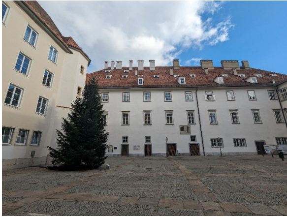
Abb. 6 Heutige Ansicht des ersten Burghofes mit Blick auf den Karlstrakt.
