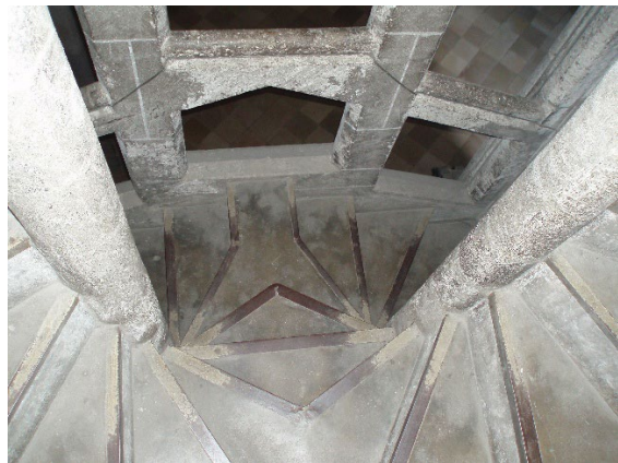
Abb. 43 Innenansicht der Zwillingswendeltreppe in Košice, Stelle der Verschmelzung der Treppenläufe.
