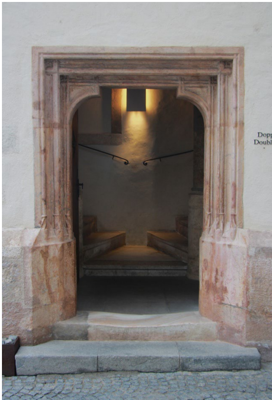
Abb. 27 Eingangsportal zur Grazer Doppelwendeltreppe.
