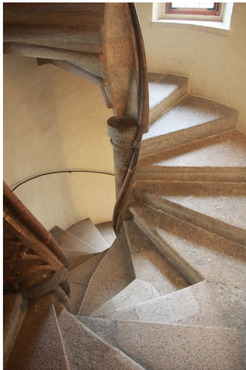
Abb. 23 Übergang der massiven Spindel zur Hohlspindel mit Kapitellabschluss unterhalb des Portals des ersten Stockwerks.
