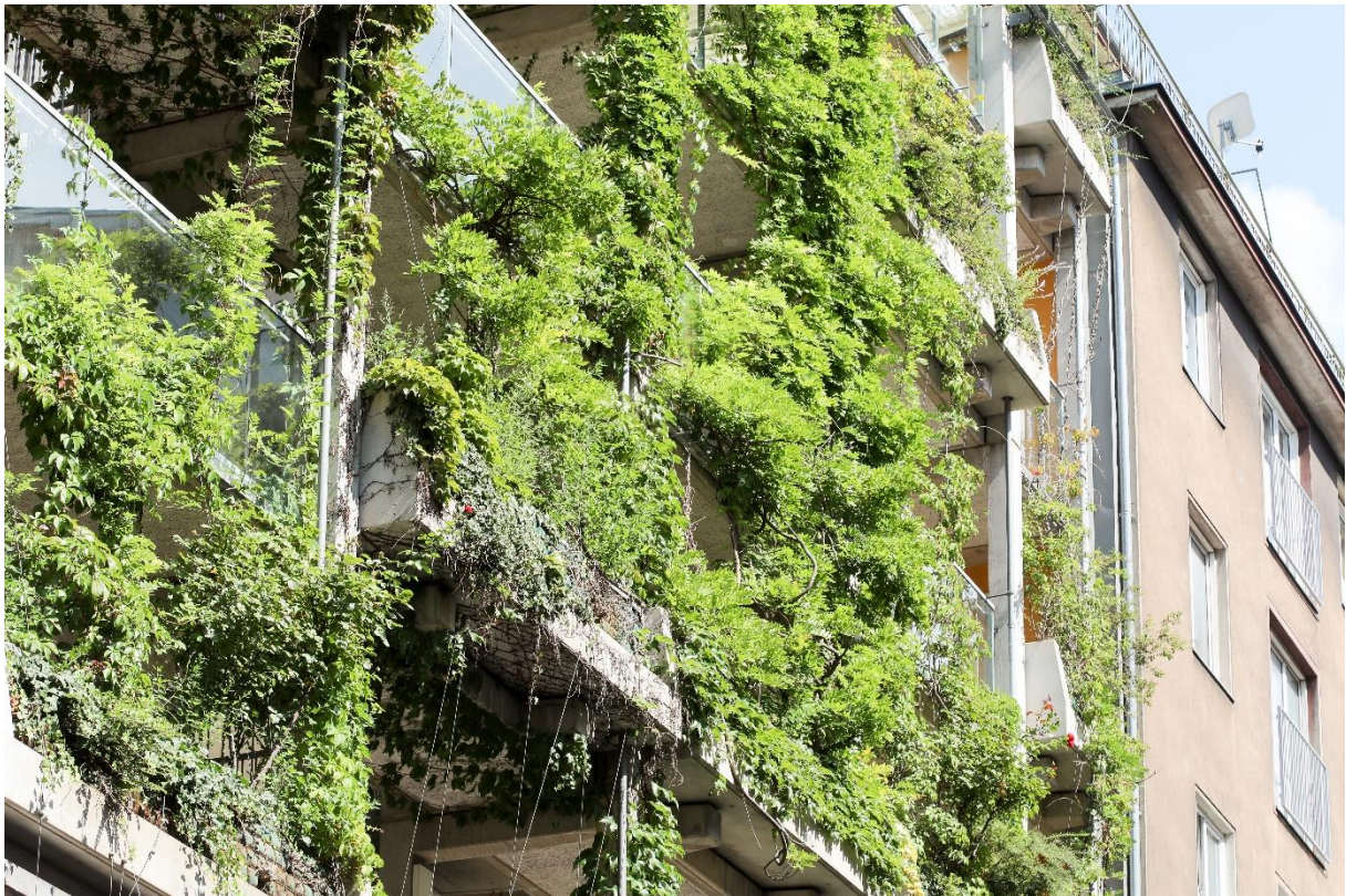
Abb. 25: Wohn- und Geschäftshaus, Fassade (Detail), Wiedner Hauptstr. 135, 1050 Wien, Österreich.
