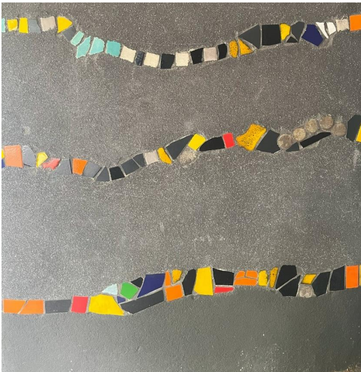
Abb. 11: Friedensreich Hundertwasser (ausführender Künstler), Peter Pelikan (Bauplanung), Josef Krawina (Miturheber), Hundertwasserhaus, Tragpfeiler (Detail), 1983-1985, Kegelgasse 36-38, 1030 Wien, Österreich.
