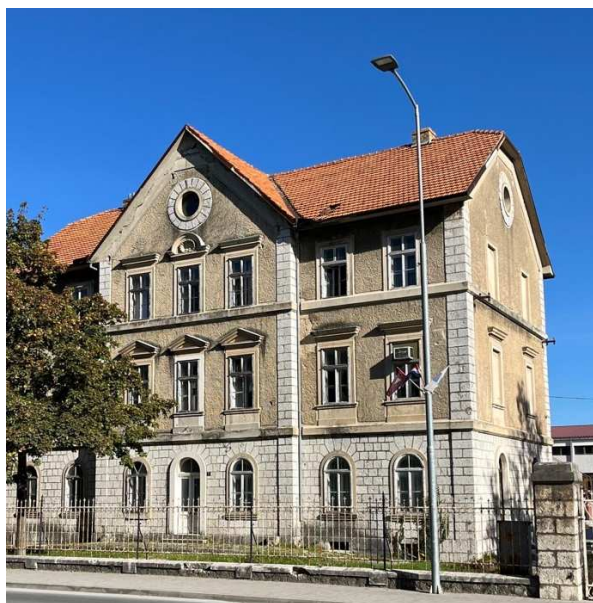
Abb. 21: Verwaltungsgebäude in Sinj, Westfassade.
