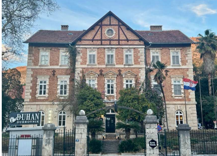
Abb. 19: Verwaltungsgebäude in Dubrovnik, Südfassade.
