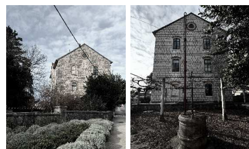
Abb. 13 / 14: Ostfassade / Westfassade, Verwaltungsgebäude in Imotski
