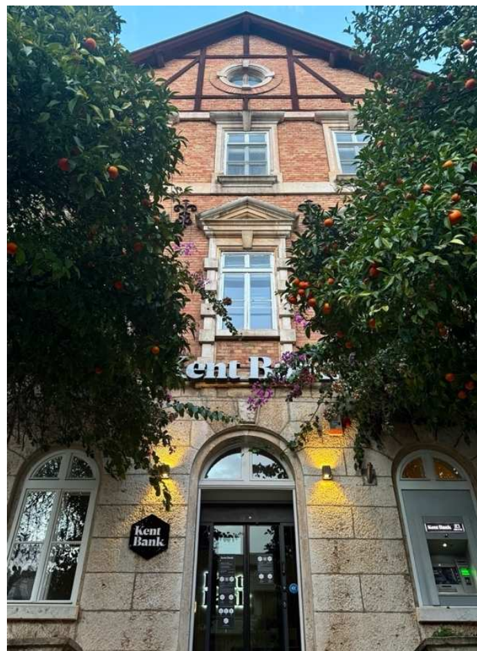
Abb. 42: Verwaltungsgebäude in Dubrovnik, Fassade.
