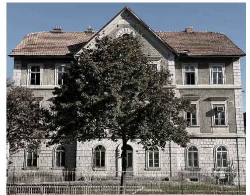
Abb. 9: Verwaltungsgebäude in Sinj, Westfassade.
