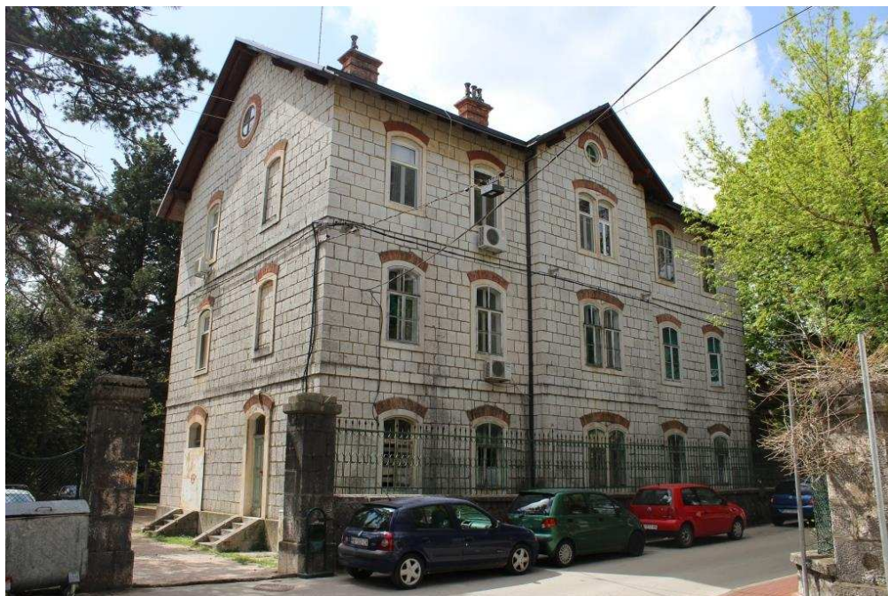
Abb. 18: Verwaltungsgebäude in Vrgorac.
