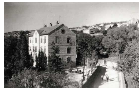
Abb. 3: Verwaltungsgebäude in Imotski, historische Fotografie.
