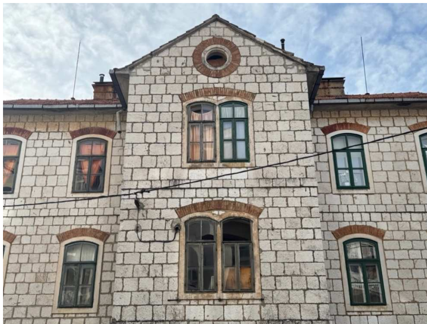
Abb. 11: Verwaltungsgebäude in Sinj, Doppelfenster.
