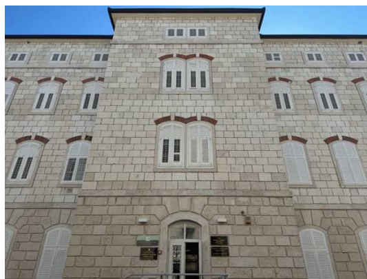
Abb. 24: Verwaltungsgebäude in Metković, Westfassade, Doppelfenster.
