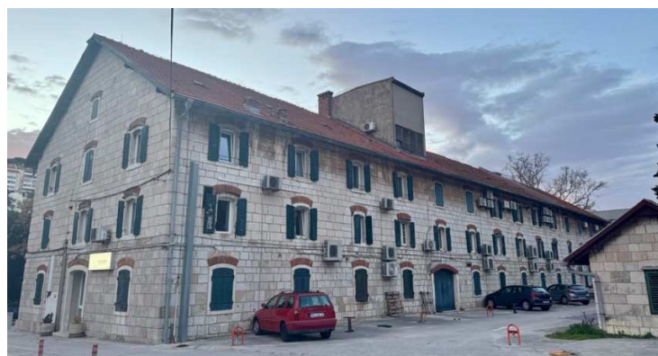
Abb. 14: Tabaklager in Dubrovnik, Nordfassade.
