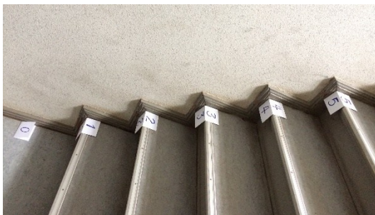
Abb. 7-3: Vorbereitung zur Zahlen-Treppe 3 (Foto d. Verf.)
