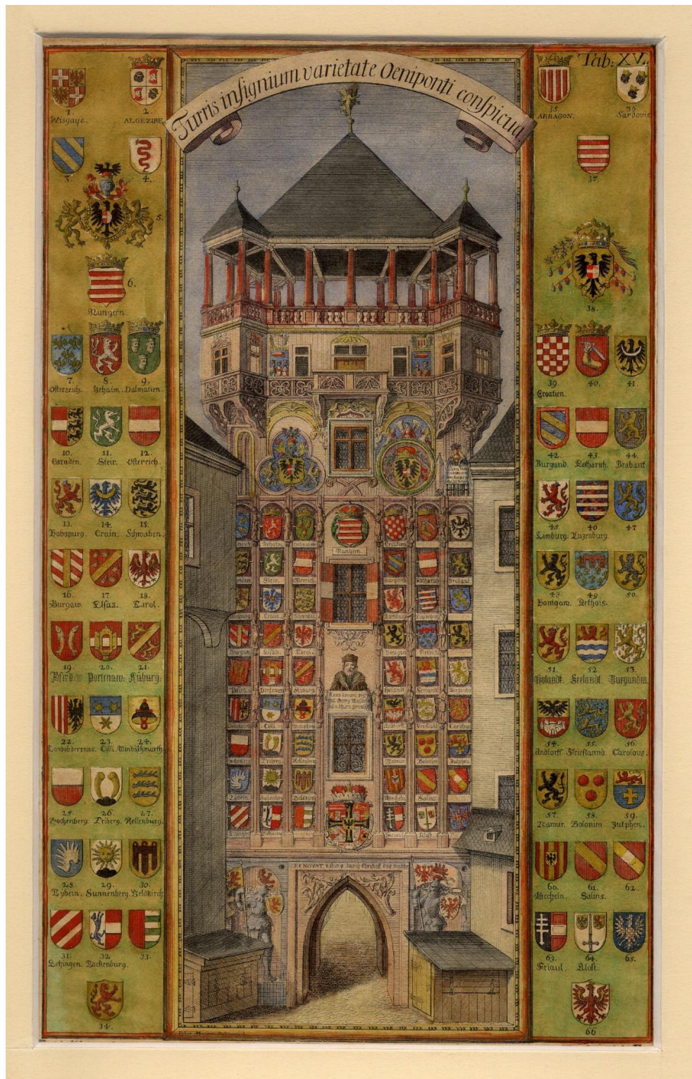
Abb. 62: Jörg Kölderer, der Wappenturm in Innsbruck, 1499, Wien, Österreichische Nationalbibliothek.
