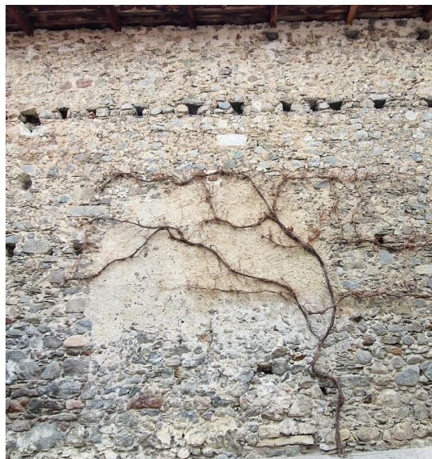
Abb. 46: Glurns, vermauerter Durchgang der nördlichen Stadtmauer am Ausgang der Silbergasse, Fotografie, 2022, Franziska Gabl.
