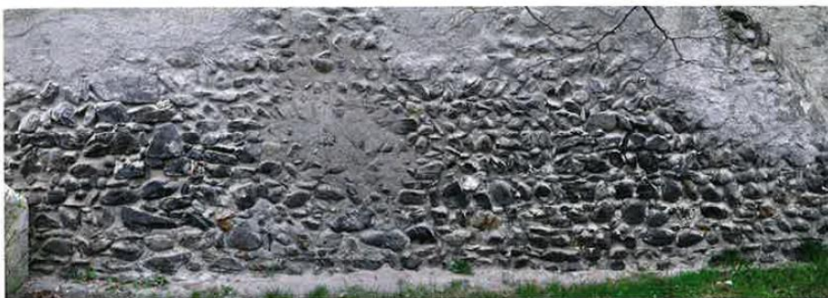
Abb. 3: Östliche Stadtmauer aus der Zeit Graf Meinhard II. von Tirol nördlich des Schludernser Torturmes mit dem gleichen Schichtmauerwerk wie südlich des Torturmes. Foto: Martin Mittermair.
