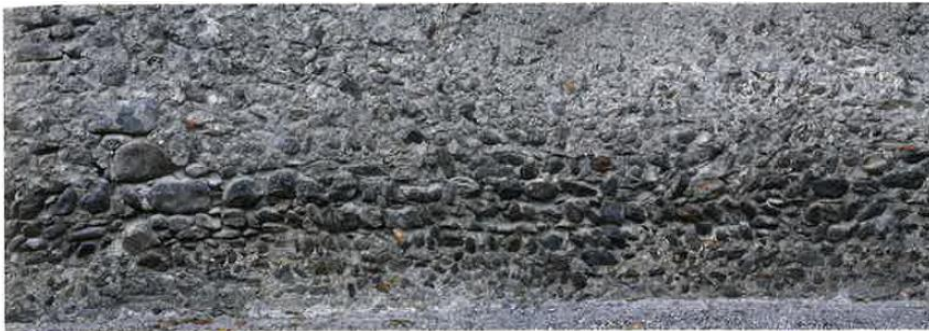
Abb. 2: Spätromantisches Lagenmauerwerk an der Außenseite der östlichen Stadtmauer südlich des Schludernser Torturmes. Foto: Martin Mittermair.
