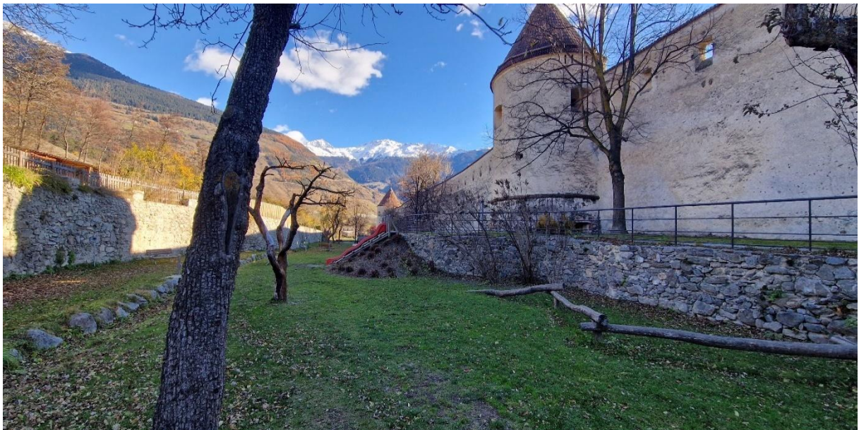
Abb. 16: Glurns, Nordseite des Stadt, heute noch erkennbare Bodenvertiefung des ehemaligen Stadtgrabens, Fotografie, 2024, Franziska Gabl.
