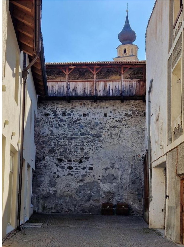
Abb.45: Glurns, vermauerter Durchgang der südlichen Stadtmauer am Ausgang der Silbergasse und Einflussort des Ischglwaals, Fotografie, 2022, Franziska Gabl.
