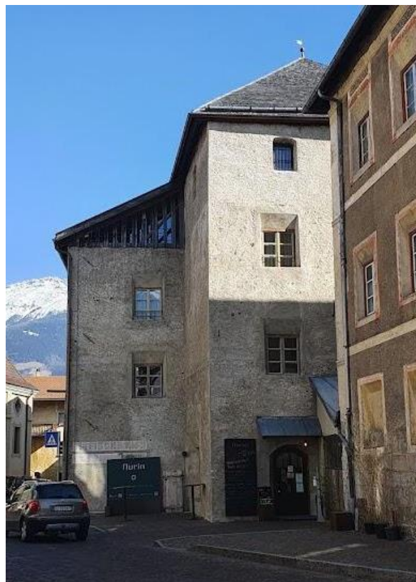
Abb. 23. Glurns, Flurinsturm, Ansicht von Westen, Fotografie, 2022, Franziska Gabl.
