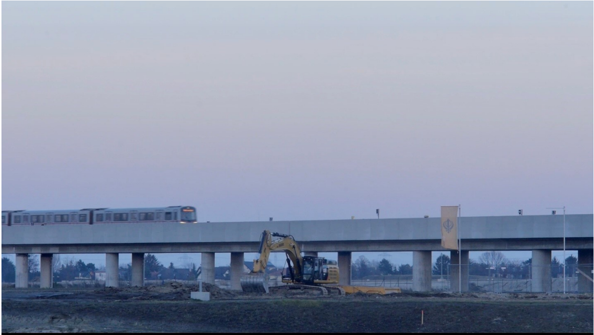
Abbildung 28: Baustelle am Abend, U-Bahn, Seestadt Aspern, 2019.
