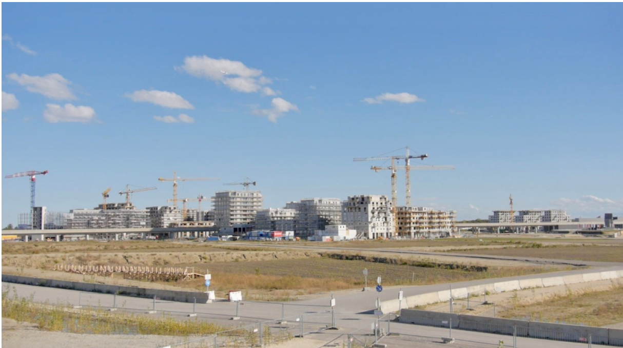
Abbildung 29: Baustelle am nächsten Tag, Blick auf Seestadt Aspern, 2020.
