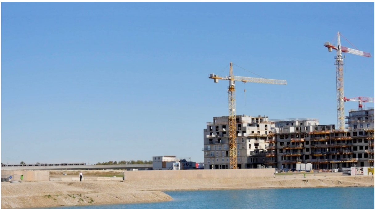
Abbildung 15: See im Zentrum der Seestadt Aspern, Baustelle, U-Bahn, 2020.
