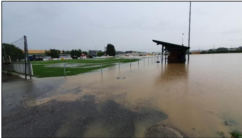
Abb. 15 Bildimpuls Hochwasser am Sportplatz 2021 (eigenes Foto)
