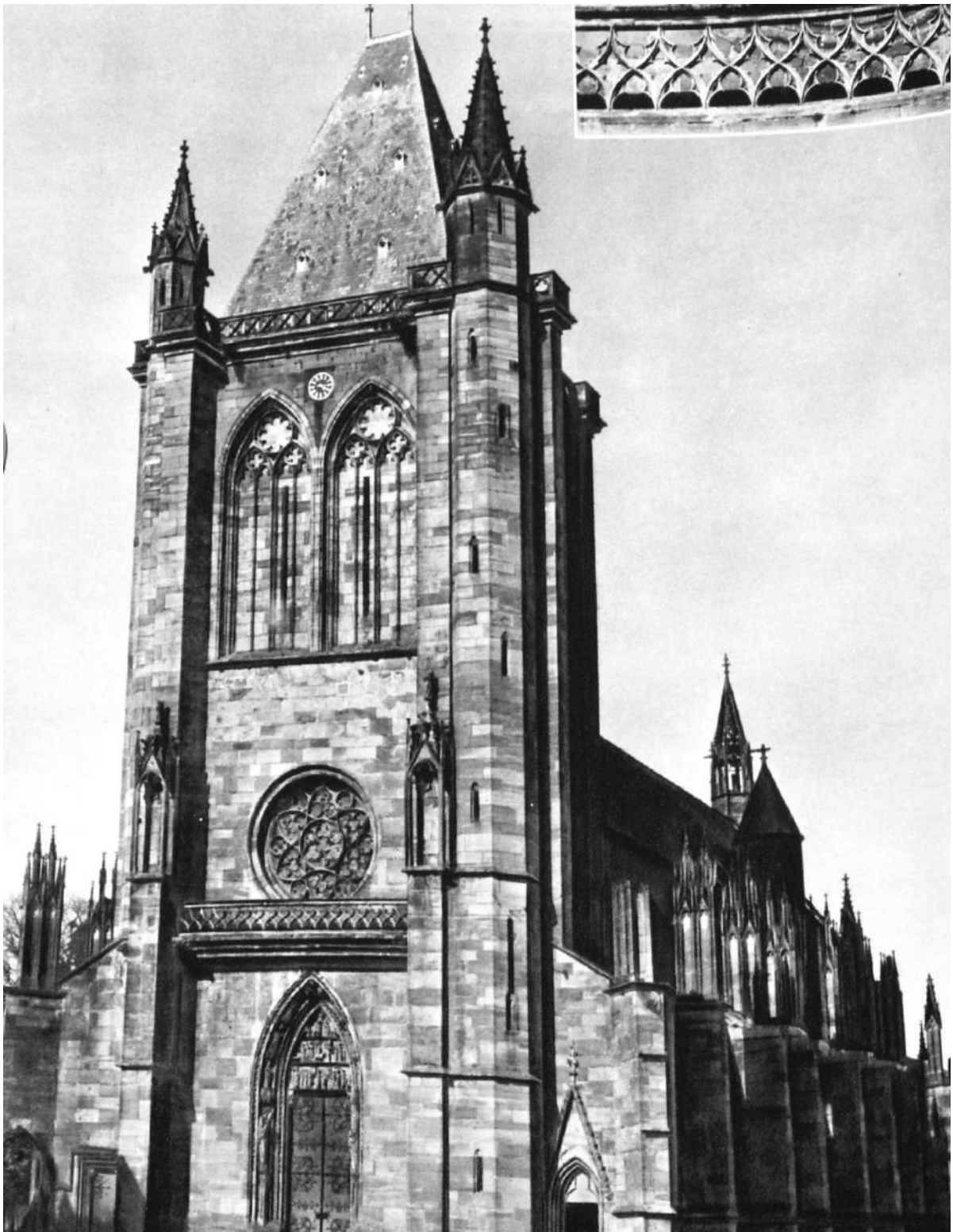
Abb. 19: Saint Florent, Niederhaslach, Westfassade. (RECHT 1974, Abb. 17.)
