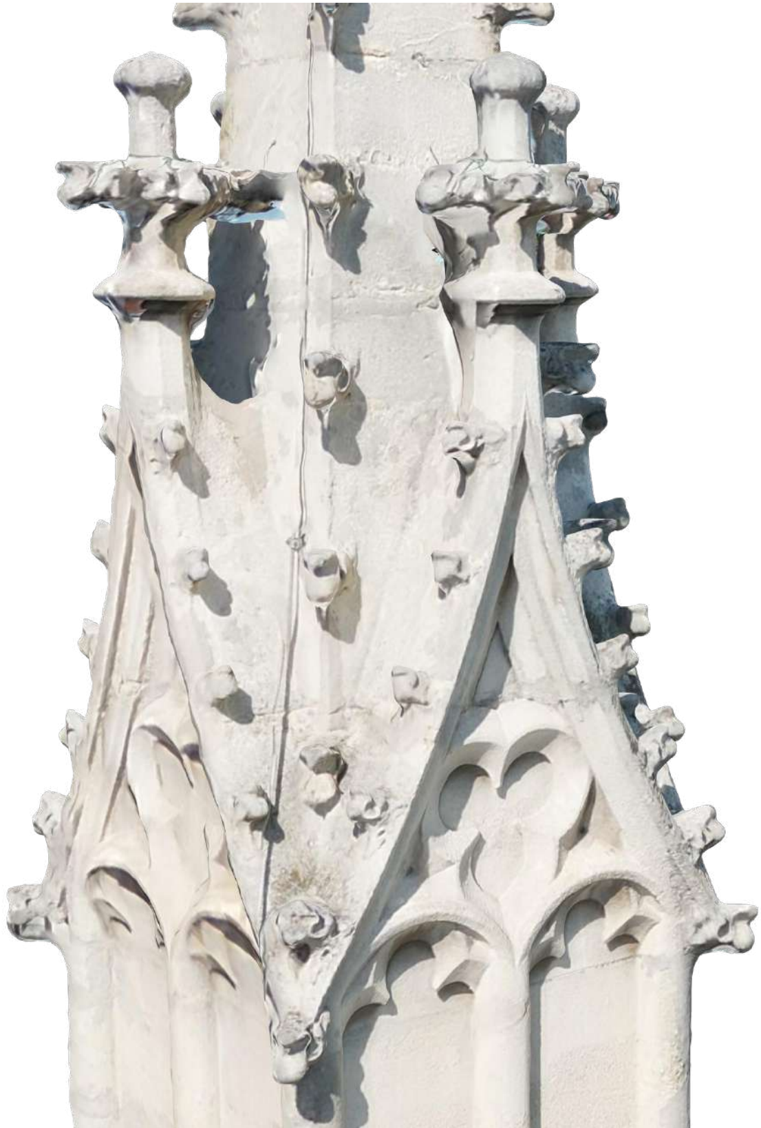
Abb. 28: Meister Michael, Maria am Gestade, 1394-1414, Wien, Konkavgiebel eines Flankenturms der Giebelzone. Fotogrammetrische Bauaufnahme (Eigene Bearbeitung, Datensatz der Fa. Archaeo Perspectives, 2024.)
