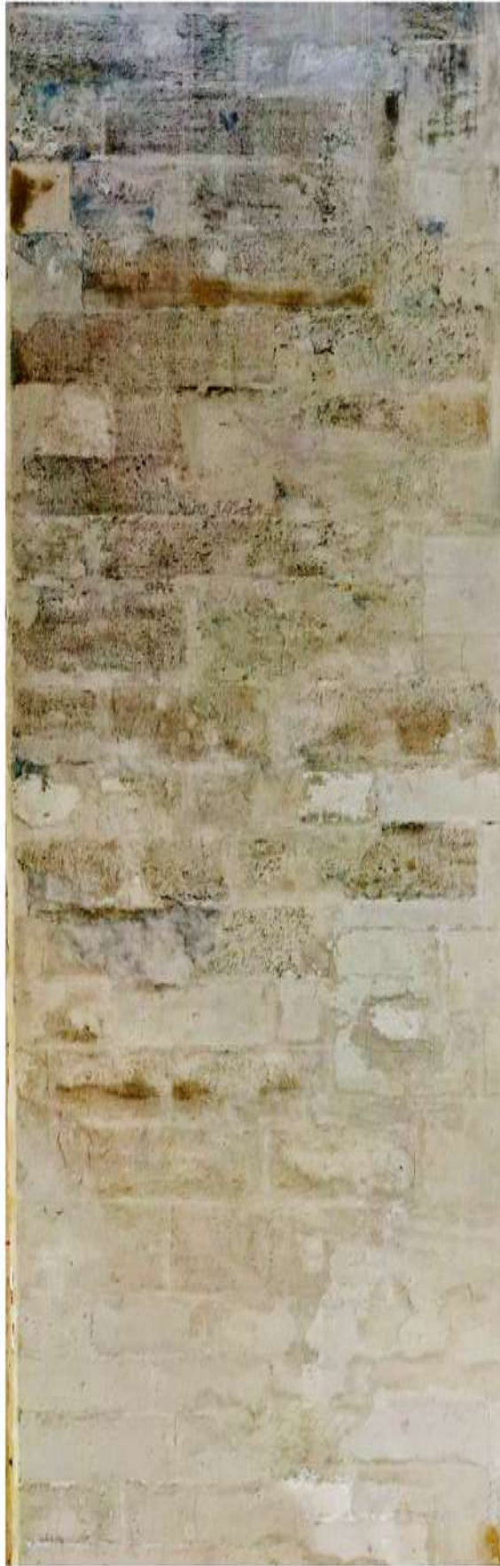
Abb. 55: Meister Michael, Maria am Gestade, 1394-1414, Wien, Portalzone (Detail, eigene Bearbeitung), unterschiedliche Gesteinsgrößen, Fotogrammetrische Bauaufnahme (Eigene Bearbeitung, Datensatz der Fa. Archaeo Perspectives, 2024.)
