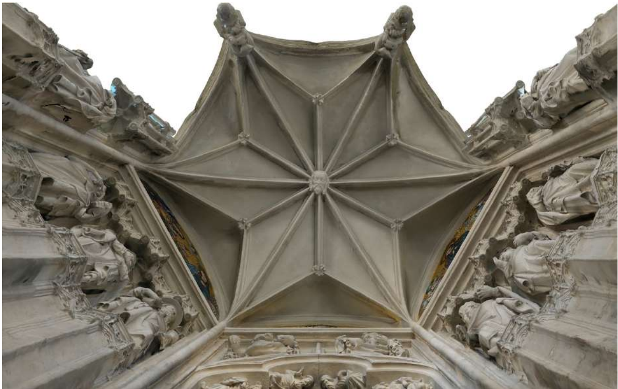
Abb. 62: Meister Michael, Maria am Gestade, 1394-1414, Wien, Portalzone (Ausschnitt), Untersicht Baldachin, Westportal, Fotogrammetrische Bauaufnahme (Datensatz der Fa. Archaeo Perspectives, 2024.)
