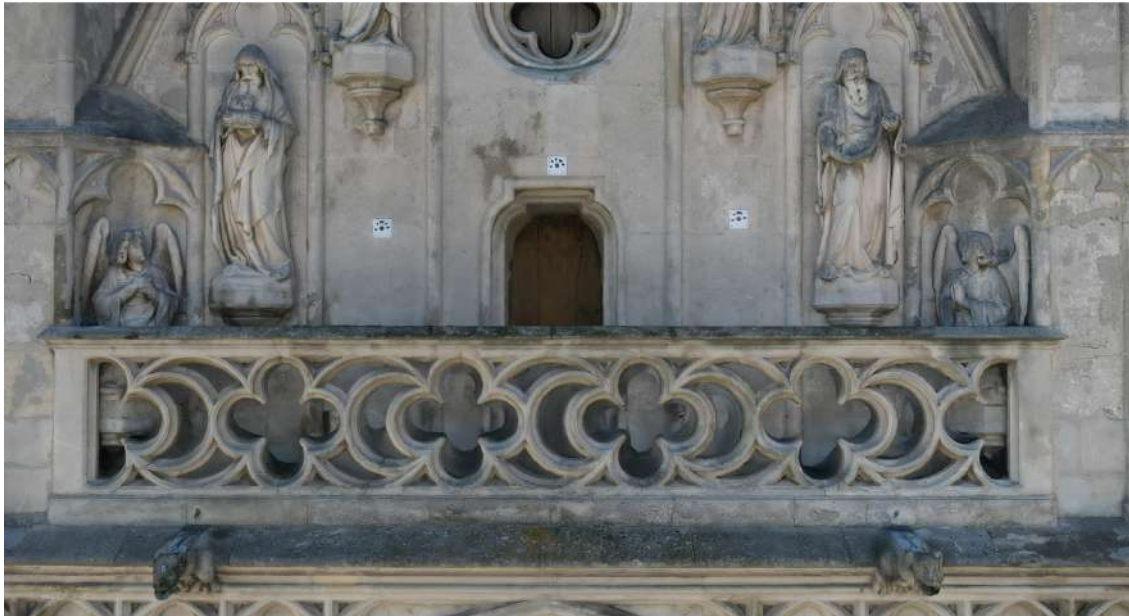
Abb. 34: Meister Michael, Maria am Gestade, 1394-1414, Wien, Brüstung in der Giebelzone, Fotogrammetrische Bauaufnahme (Eigene Bearbeitung, Datensatz der Fa. Archaeo Perspectives, 2024.)
