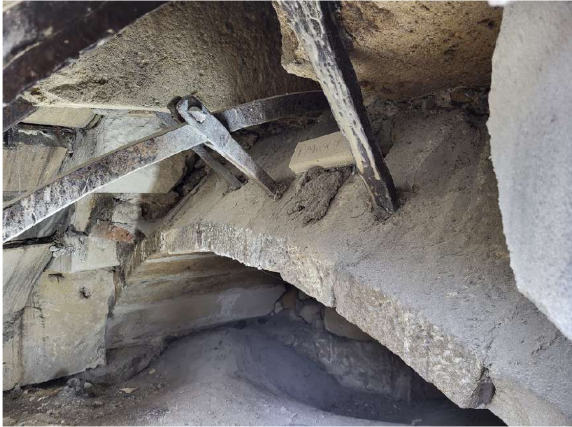
Abb. 94: Maria am Gestade. Eisenkonstruktion des Kuppelbaldachins über dem Westportal. (Bernleitner, Johannes (Fotograf), Fa. Ecker, Bestandsaufnahme. Wien, 2023. )
