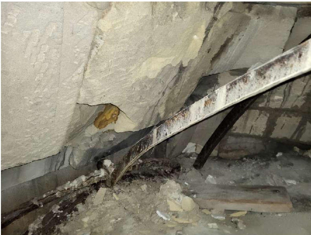
Abb. 66: Meister Michael, Maria am Gestade, 1394-1414, Wien, Eisenkonstruktion des Kuppelbaldachins über dem Westportal (Bernleitner, Johannes (Fotograf), Fa. Ecker, Bestandsaufnahme. Wien, 2023. )
