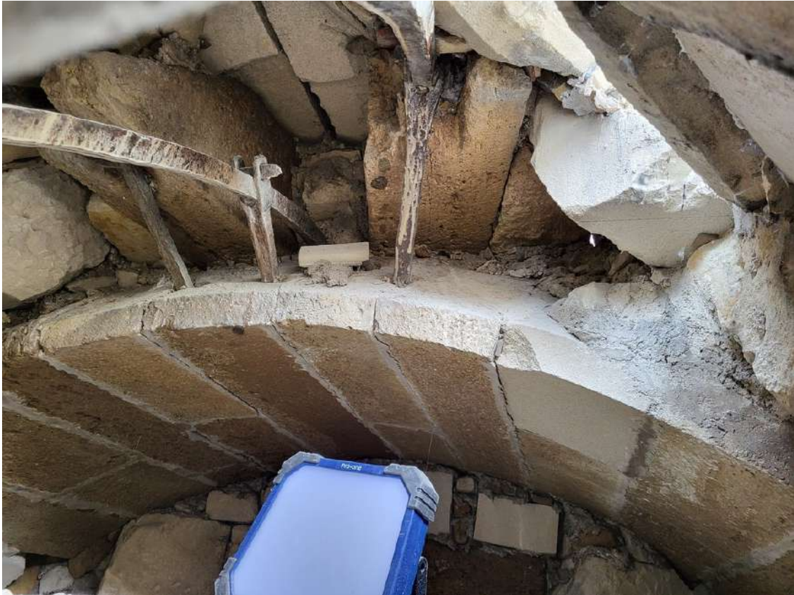
Abb. 67: Meister Michael, Maria am Gestade, 1394-1414, Wien, Eisenkonstruktion des Kuppelbaldachins über dem Westportal (Bernleitner, Johannes (Fotograf), Fa. Ecker, Bestandsaufnahme. Wien, 2023. )
