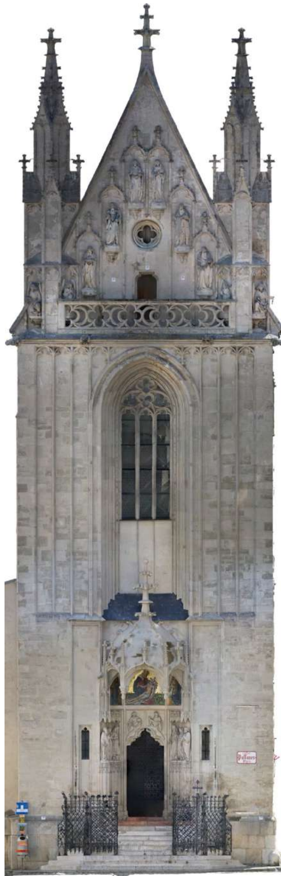
Abb. 13: Meister Michael, Maria am Gestade, 1394-1414, Wien, Westfassade, Fotogrammetrische Bauaufnahme. (Eigene Bearbeitung, Datensatz der Fa. Archaeo Perspectives, 2024.)
