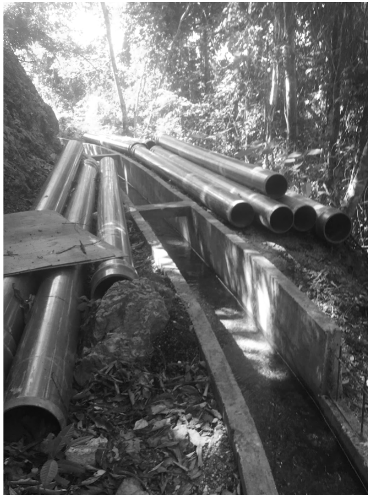
Abbildung 3 Momentaufnahme der Verlegung neuer Wasserrohre neben einem Wasserlauf in Form eines Aquädukts in Tubig Tobod (Helmus 2020)
