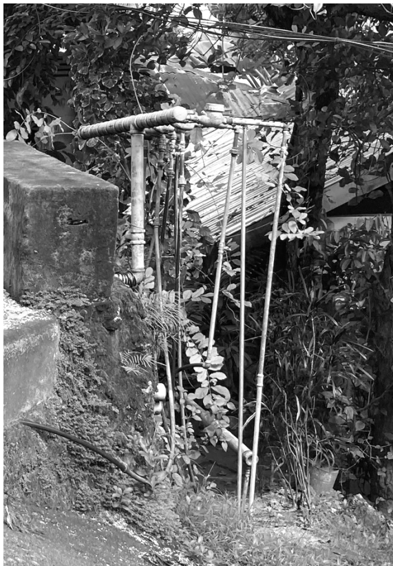
Abbildung 14 Wasserzähler an der Verteilungsleitung am Straßenrand in Larena. Im Hintergrund sind Haushalte zu sehen (Helmus 2023)
