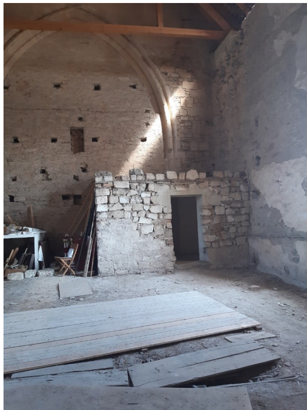
Abb. 84: Eggenburg, Pfarrkirche, westlicher Emporenbau, Blick auf den nachträglich eingebauten Vorraum zum Treppenturm.
