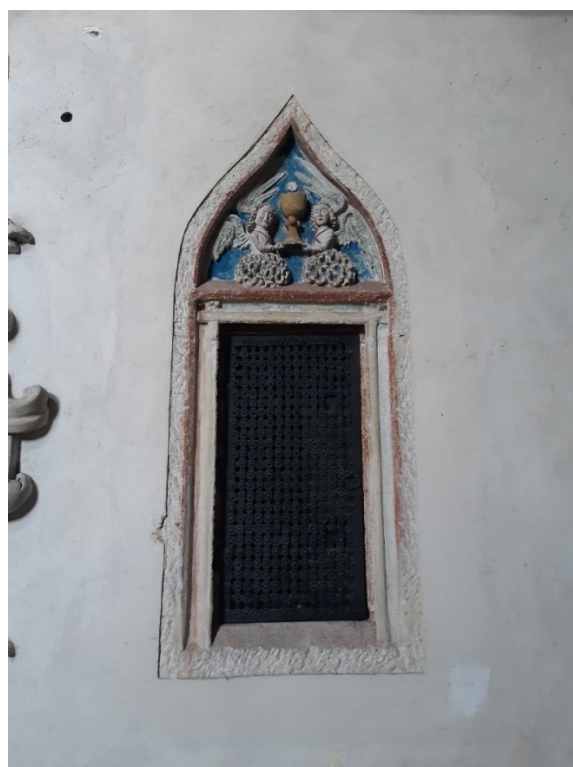
Abb. 48: Eggenburg, Pfarrkirche, Chor, Nordwand, altes Sakramentshaus, 14. Jahrhundert.
