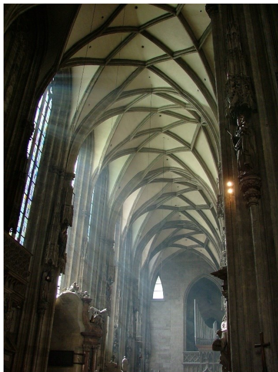
Abb. 90: Wien, Stephansdom, Langhaus, südliches Seitenschiff mit Fenster zur Bartholomäuskapelle, Blick Richtung Westen.
