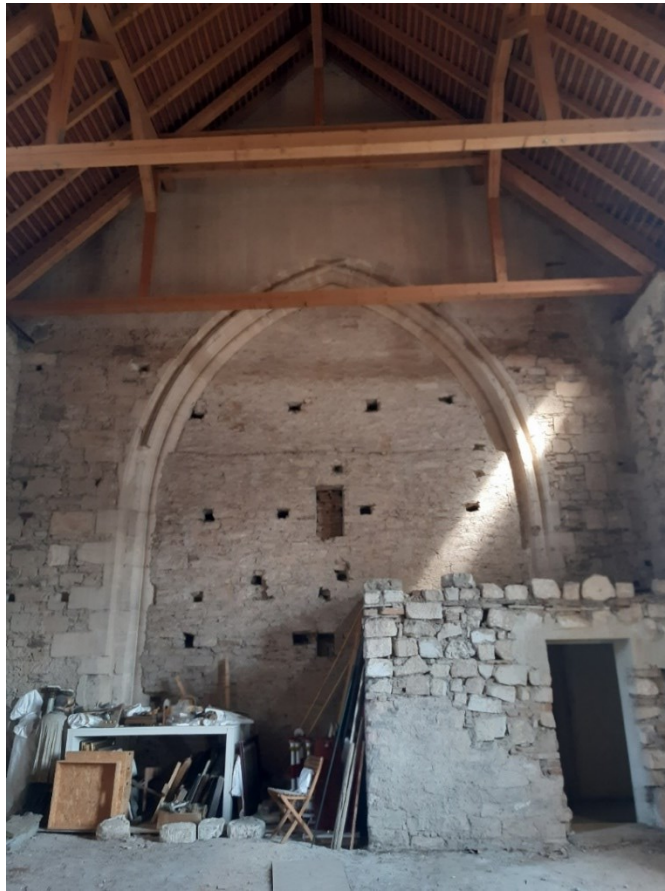
Abb. 23: Eggenburg, westlicher Emporenbau, Inneres, vermauerte Bogenöffnung in Richtung Langhaus.
