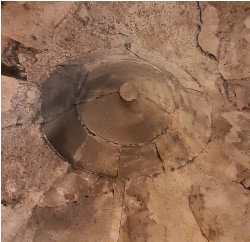
Abb. 82: Eggenburg, Pfarrkirche, Treppenturm neben dem westlichen Emporenbau, Gewölbe.
