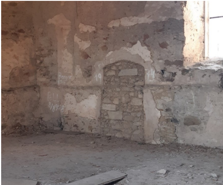
Abb. 89: Eggenburg, Pfarrkirche, westlicher Emporenbau, Nordwand, vermauertes Tor zum ehem. Wehrgang der Stadtmauer.
