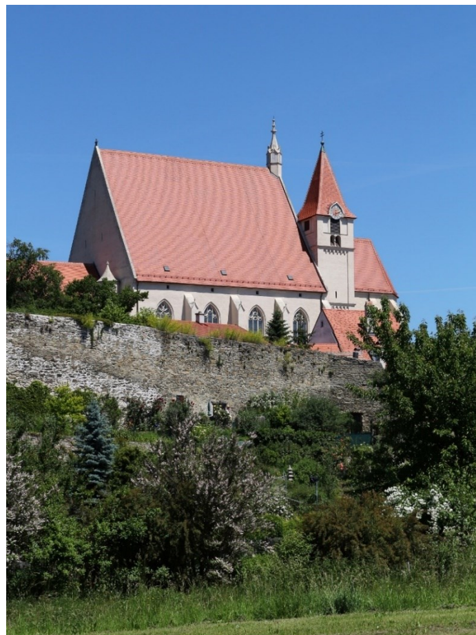
Abb. 20: Eggenburg, Pfarrkirche, davor Stadtmauer, Ansicht von Süden.
