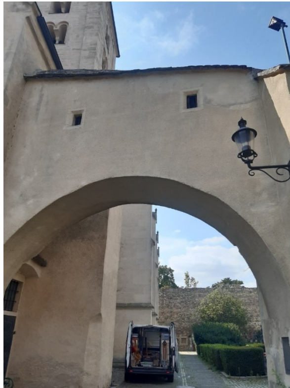
Abb. 131: Eggenburg, Pfarrkirche, Verbindungsgang zwischen Sakristei und altem Pfarrhof, südlicher Schwibbogen mit darüberbefindlichen kleinen Fenstern.
