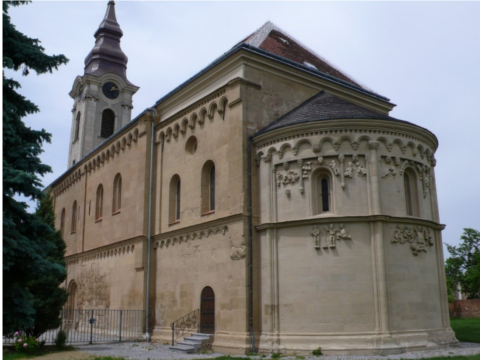
Abb. 27: Schöngrabern, Pfarrkirche, Ansicht von Südosten.
