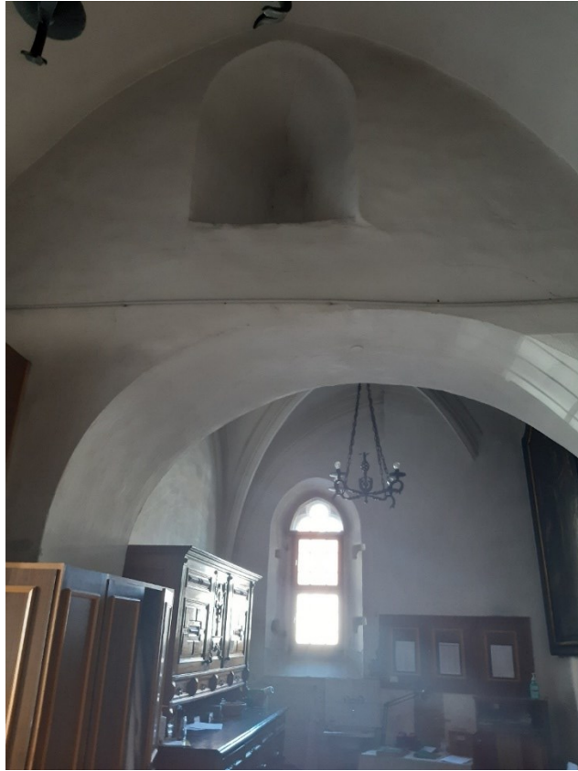
Abb. 55: Eggenburg, Pfarrkirche, Sakristei, Blick vom ersten Raum in den zweiten.
