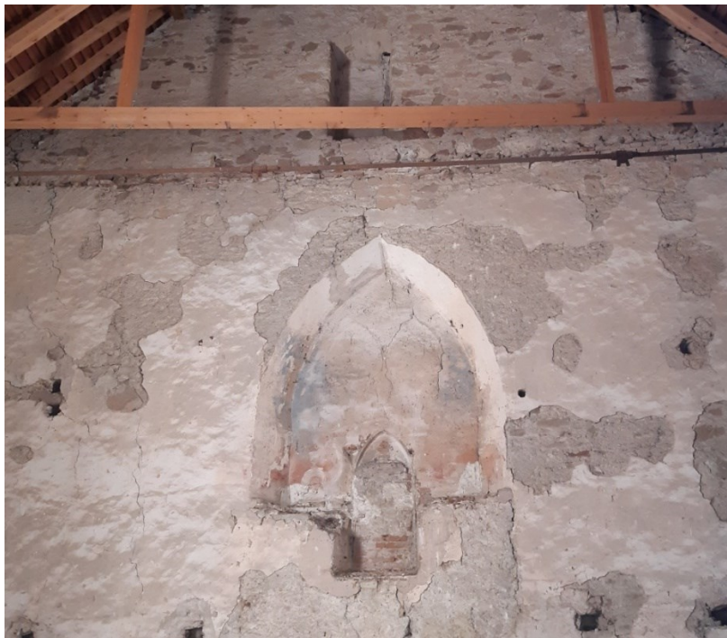
Abb. 86: Eggenburg, Pfarrkirche, westlicher Emporenbau, vermauertes Westfenster von innen, Spuren von neuzeitlicher Bemalung.
