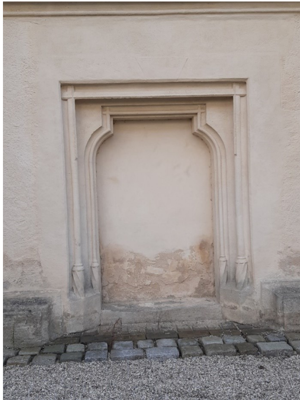
Abb. 67: Eggenburg, Pfarrkirche, Langhaus, Nordwand, ehem. Portal, 15. Jahrhundert.
