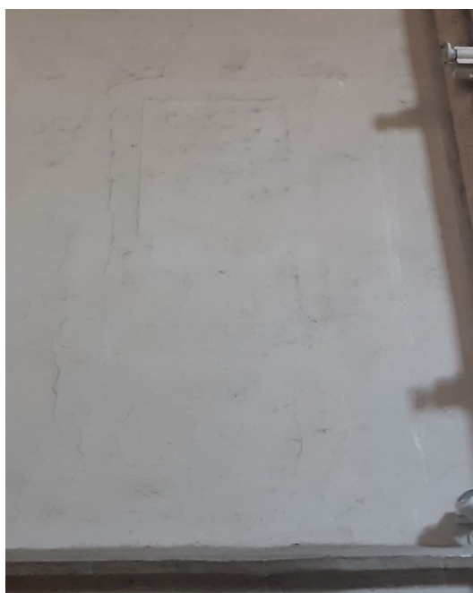
Abb. 47: Eggenburg, Pfarrkirche, Chor, Südwand, vermauerte Tür.
