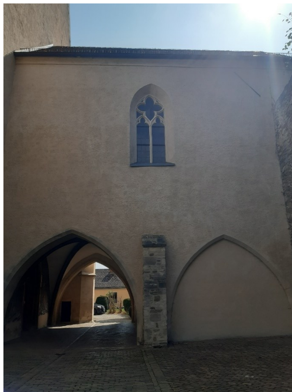
Abb. 6: Eggenburg, Pfarrkirche, westlicher Emporenbau mit Verbindung zur Stadtmauer.
