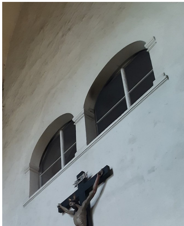
Abb. 52: Eggenburg, Pfarrkirche, Chor, Nordwand, barockes Zwillingsfenster zum Oratorium über der Sakristei.
