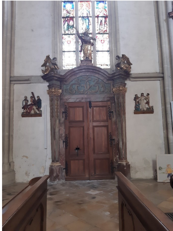
Abb. 69: Eggenburg, Pfarrkirche, Langhaus, Nordwand, heute vermauertes Portal mit noch vorhandener Tür, 18. Jahrhundert.
