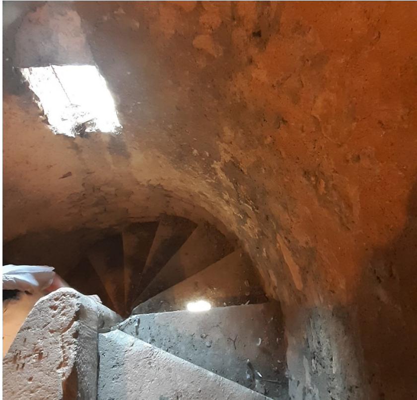
Abb. 81: Eggenburg, Pfarrkirche, Treppenturm neben westlichen Emporenbau, Wendeltreppe.
