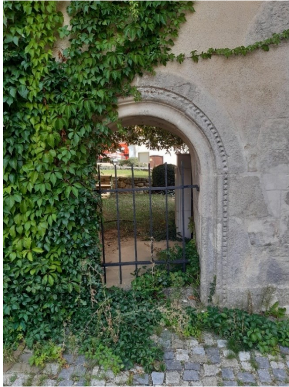
Abb. 133: Eggenburg, Pfarrkirche, Verbindungsgang zwischen Sakristei und altem Pfarrhof, romanisches Portal im Erdgeschoß der ehemaligen Bruderschaftsstube, Ansicht von Westen.
