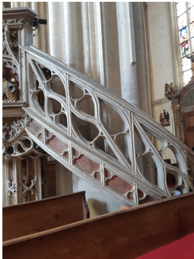
Abb. 110: Eggenburg, Pfarrkirche, Langhaus, Kanzel, Aufgang, Geländer mit Fischblasenmaßwerk, datiert 1515.
