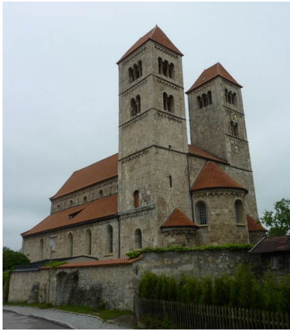
Abb. 25: Altenstadt in Bayern, Basilika, Ansicht von Südosten.
