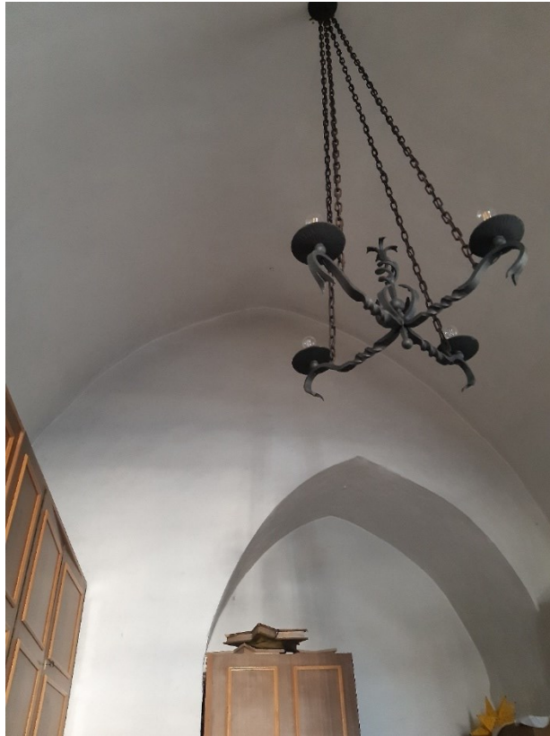
Abb. 53: Eggenburg, Pfarrkirche, Sakristei, erster Raum, Gewölbe.
