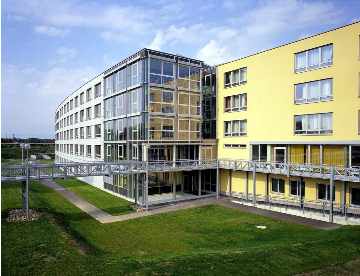
Abb. 41: Georg W. Reinberg, Pensionisten- und Pflegeheim, Außenansicht, 2000, St. Pölten.
