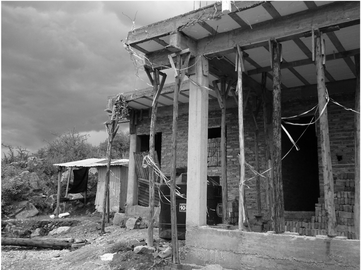
Abbildung 6: Dekoration für die Zeremonie der Ch'alla an einem noch unfertigen Haus (Quelle: Agnes Sieben)
