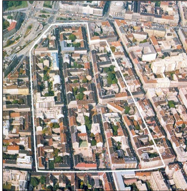
Abbildung 10: Gebietsbetreuung Gumpendorf, Luftaufnahme. Links oben der Europaplatz mit dem Westbahnhof. Gut sichtbar sind die in den 1980er Jahren errichteten Neubauten.
