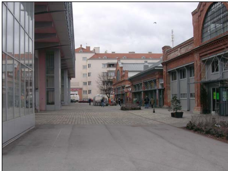
Abbildung 13: Remise Kreuzgasse nach der Sanierung.
