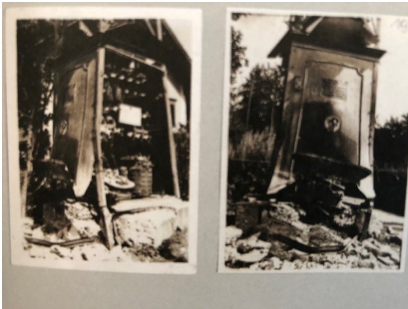
Abbildung 14: Böllersschläge auf Trafostationen in Lustenau.
