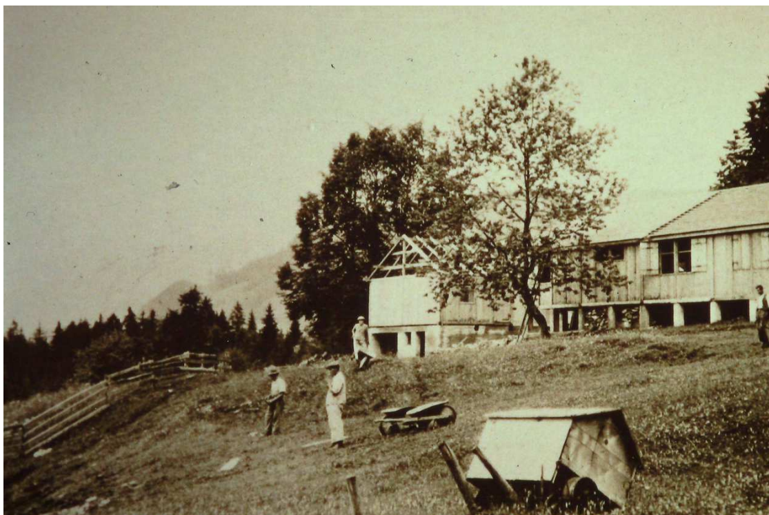
Abb. 3: Bau des Kriegsgefangenenlagers Übersaxen
