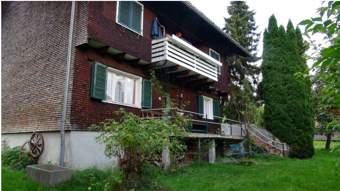
Abb. 2: Auf dem Keller der Kanzlei des ehemaligen Zwangsarbeiterlagers wurde später ein Wohnhaus errichtet.
