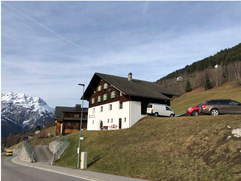
Abb. 3: Bergstation der Materialseilbahn von Schruns nach Bartholomäberg
