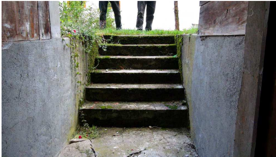
Abb. 3: Außenstiege des Kanzleigebäudes des Zwangsarbeiterlagers.
