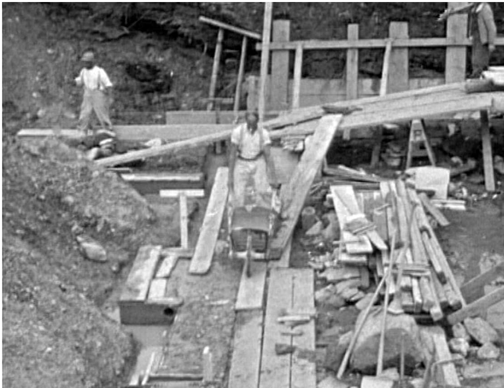
Abb. 2: Der Neubau der Molkerei Riezern war eine der bedeutendsten Aufbaumaßnahmen.
