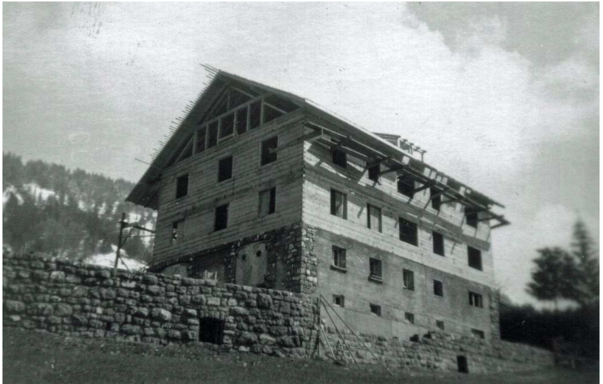
Abb. 3: Das Dorfwirtschaftshaus im Rohbau, Südseite; unten in der Steinmauer: zwei Drainageöffnungen
