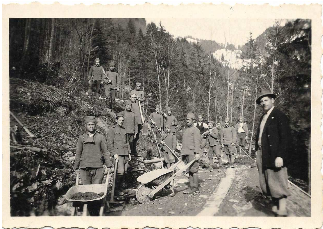
Abb.10: Winterbaustelle Fadratzaweg: Zum Steintransport wurde eine Rollbahn errichtet.
