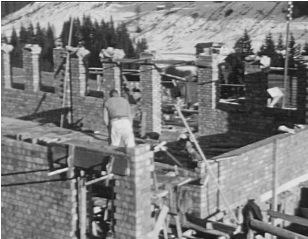
Abb. 3: Hochziehen der Mauern für die Molkerei in Riezern
