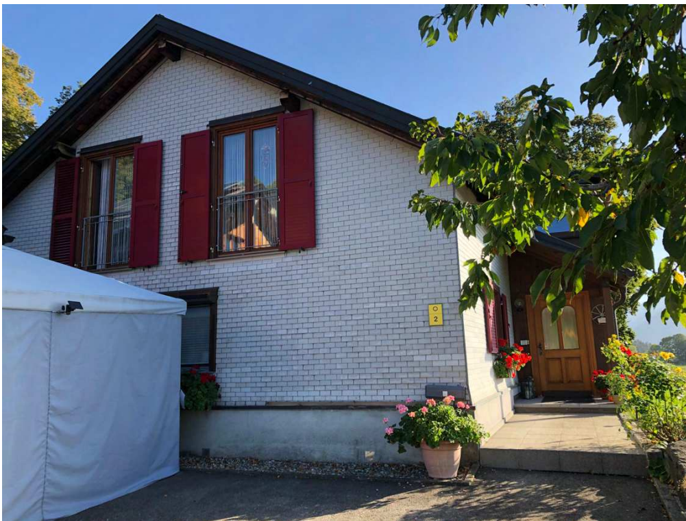
Abb. 2: Die Kanzlei des ehemaligen Kriegsgefangenenlagers ist zum Wohnhaus umgebaut worden.
