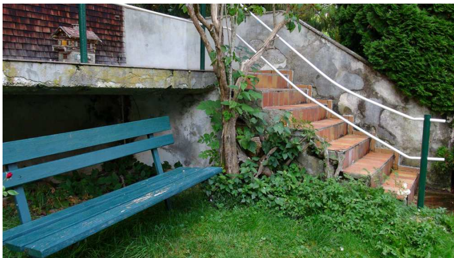
Abb. 5: Diese Treppe führt zum Wohnhaus, das auf dem Keller des ehemaligen Kanzleigebäudes errichtet wurde.
