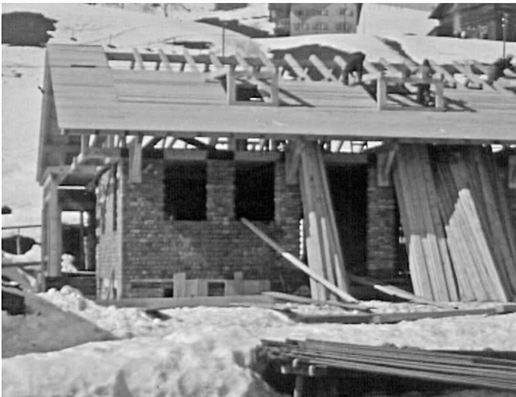
Abb. 4: Zimmermannsarbeiten beim Molkereineubau in Riezern
