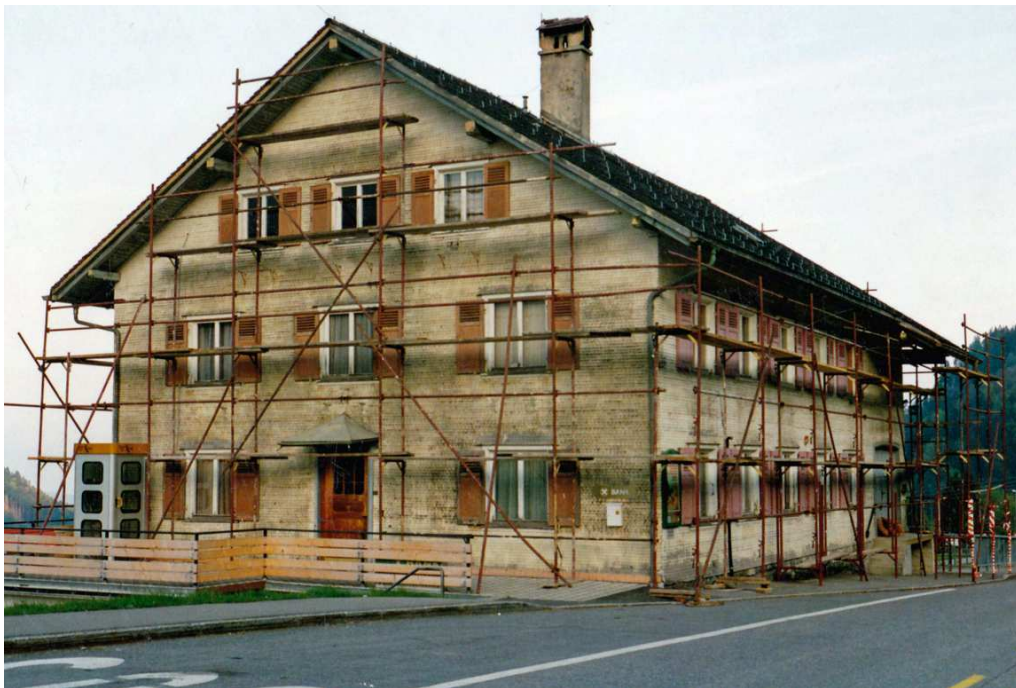
Abb. 2: Renovierung des Gemeindehauses im Jahr 1991 (zu sehen: Ost- und Nordseite)
