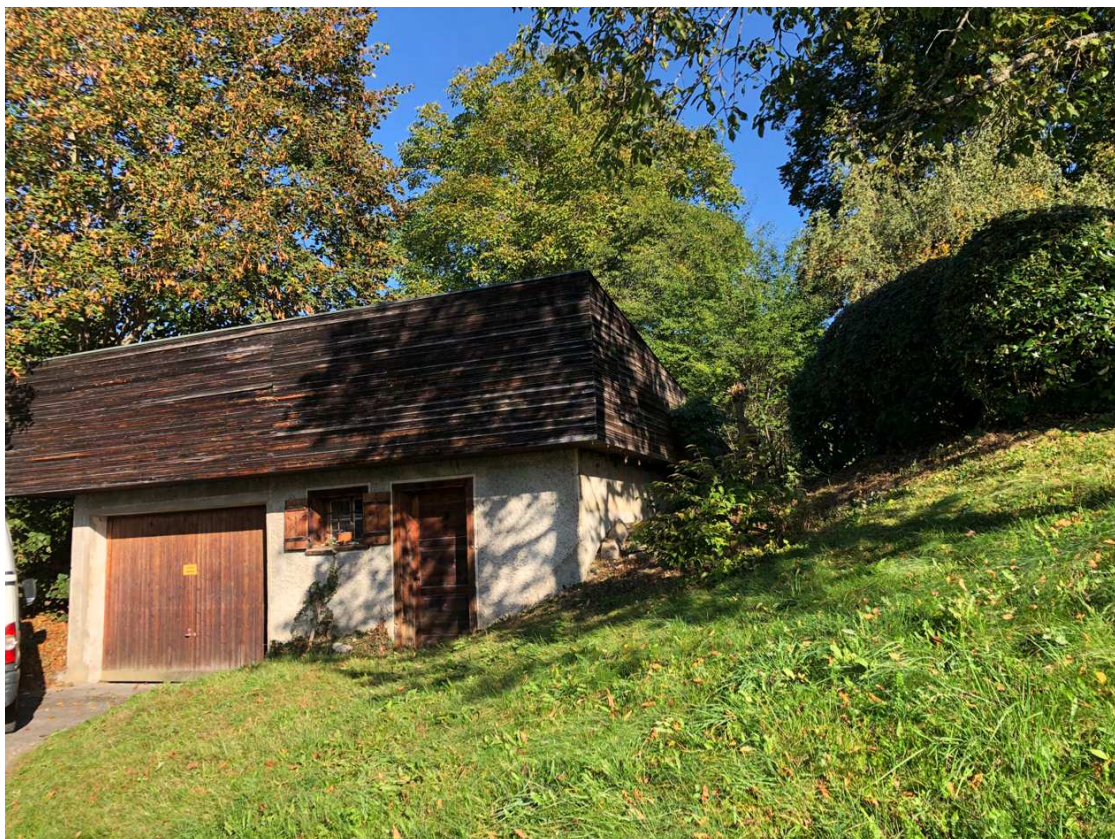
Abb. 4: Auch die Garage des ehemaligen Kriegsgefangenenlagers steht heute immer noch.
