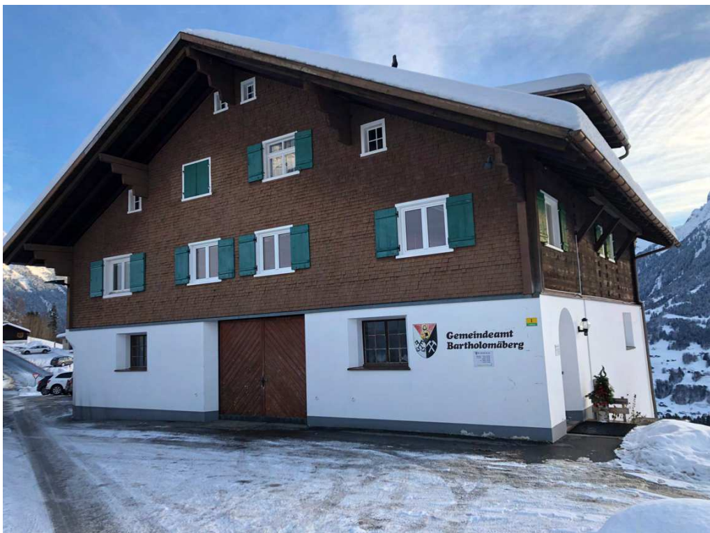
Abb. 4: Die Seilbahn-Bergstation war auch Dorfwirtschaftshaus. Heute sind hier das Gemeindeamt und der Bauhof untergebracht.
