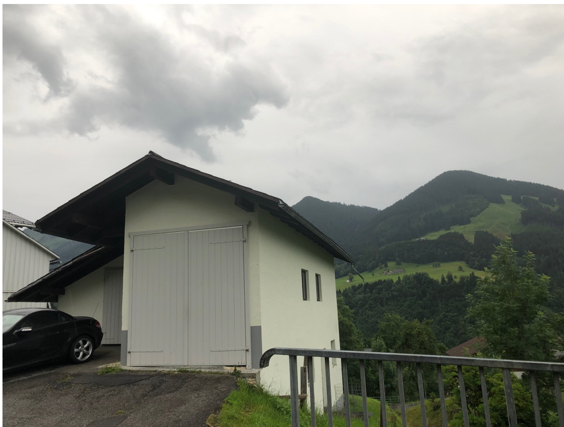
Abb. 9: Ehemalige Talstation der Materialseilbahn auf die Alpe Wies beim Haus Laternserstraße 18.
