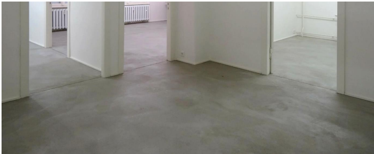
Abbildung 2: typischer Zustand des Estrichs vor Verlegung des Gehbelags 143
