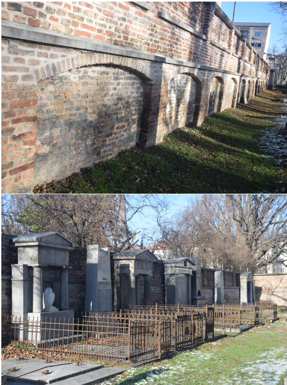
Abbildung 4.4: Oben: Aussparungen in der erhaltenen Mauer des jüdischen Friedhofs. Unten: Gräfte mit stehenden, massiven Grabsteinen entlang der Mauer.
