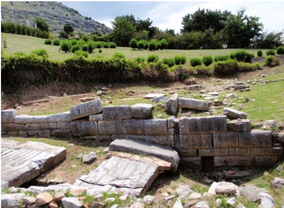
Abb. 5: Unterste Steinlage der westlichen Wand von Haus I aus der hellenistischen Phase, Steinquader aus lokalem Marmor und in pseudoisodomer Verlegetechnik, Philippi, Ostmakedonien, Nordgriechenland.
