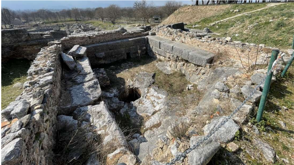
Abb. 8: Hellenistischer Tempel, Atrium Basilika A (um 500 n. Chr.), unterste Steinlage große Quader aus lokalem Marmor in pseudoisodomer Verlegetechnik, Philippi, Ostmakedonien, Nordgriechenland.
