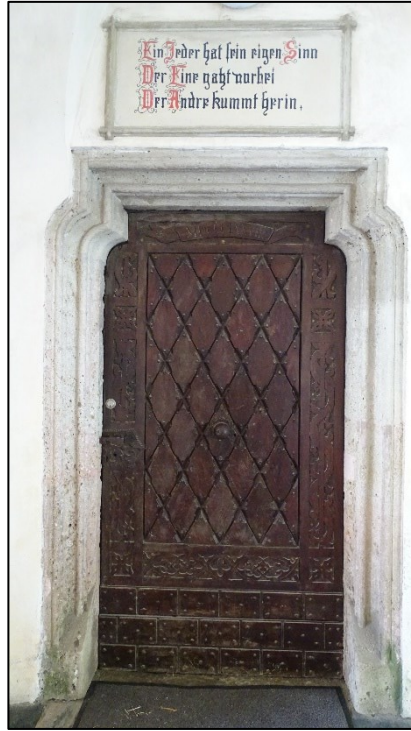
Abbildung 83: reichgeschnitzte Holztüre mit Jahreszahl 1878 im Durchfahrtsqewölbe.
