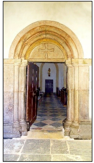
Abbildung 78: zweistufiges romanisches Säulenportal als Spolie,
