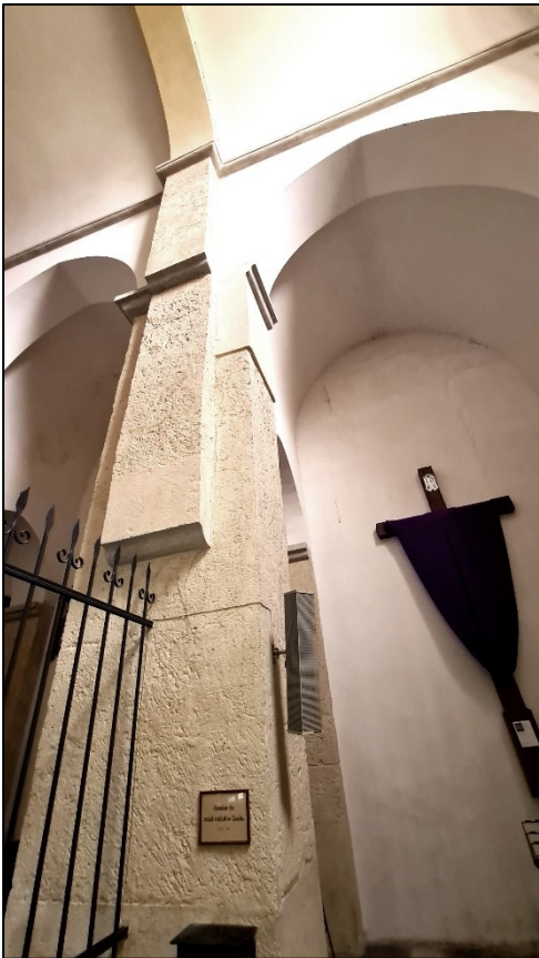
Abbildung 38: spitzbogige Arkaden und Kämpfergesims.
