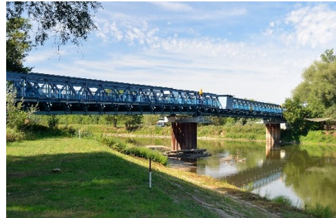
Abbildung 92: Stahlbrücke in Hohenau (Wikimedia 2012).
