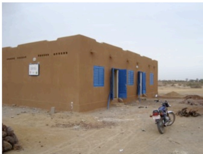
Abbildung 3.10: Neu erbaute Lagerhalle in Sanankoroba 217
