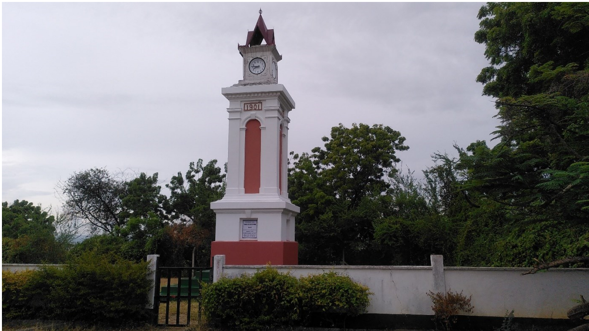
Abbildung 18: Uhrenturm aus der Zeit des deutschen Kolonialismus nach der Renovierung
