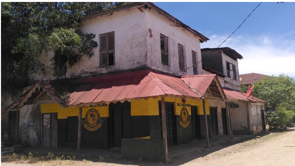
Abbildung 20: Gebäude aus der deutschen Kolonialzeit im historischen Stadtzentrum Panganis. Erbaut am 1. Juli 1910
