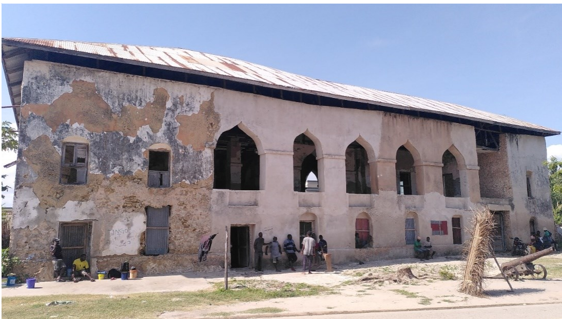
Abbildung 13: Außenansicht des ehemaligen deutschen Bomas in Kilwa Kivinje nach der Renovierung (2023)
