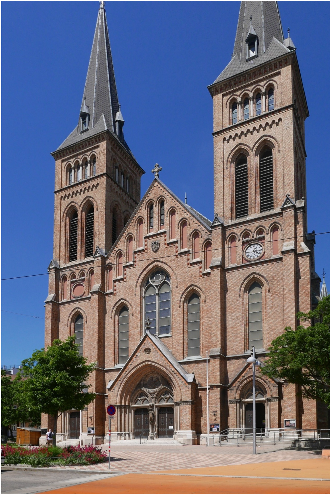
Abbildung 59, Pfarrkirche Neuottakring Wien XVI, Abb. des Autors, 2021.
