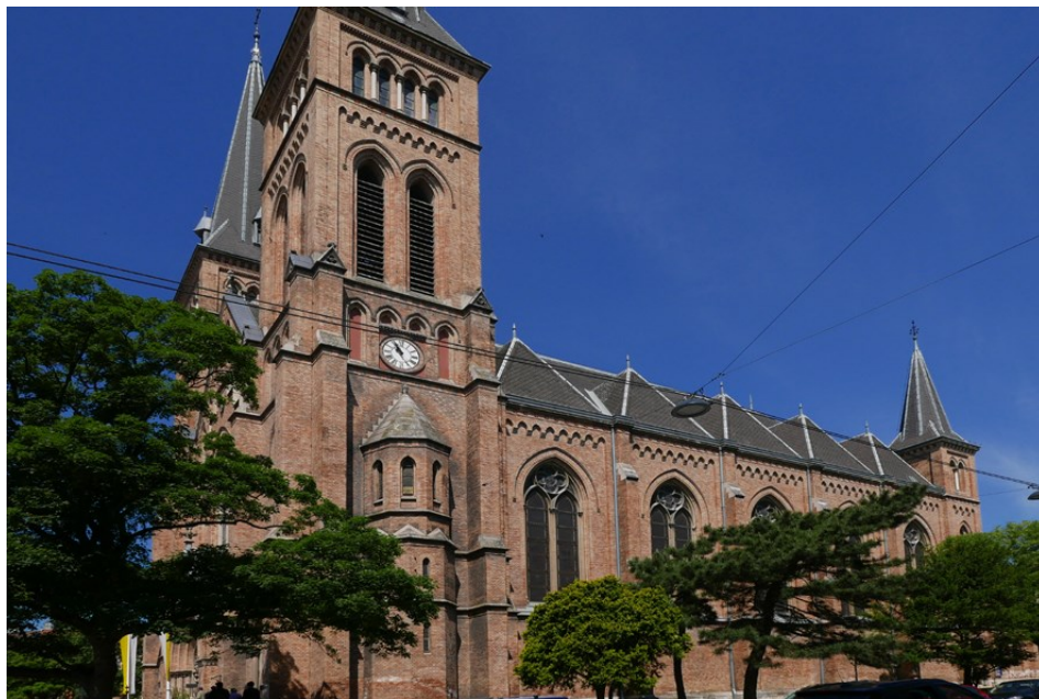
Abbildung 61, Pfarrkirche Neuottakring, Abb. des Autors, 2021.
