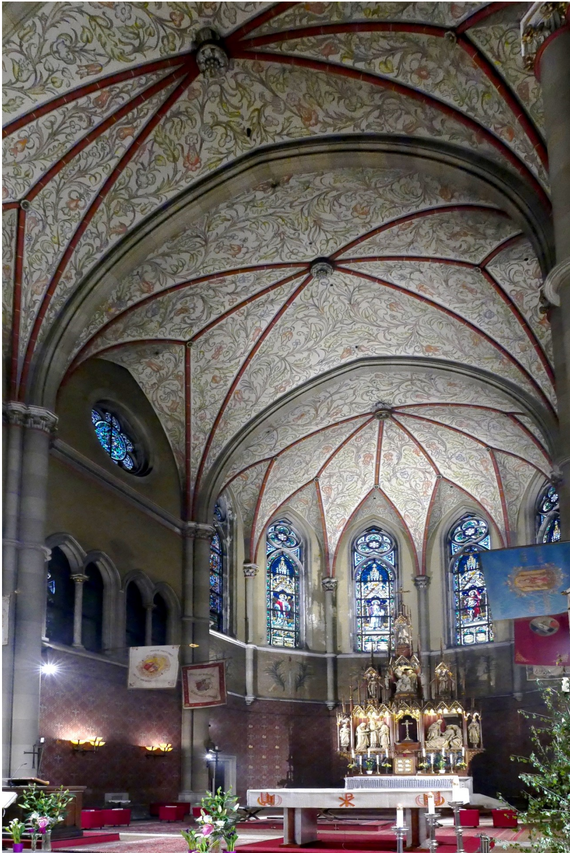
Abbildung 64, Pfarrkirche Neuottakring, Presbyterium, Abb. des Autors, 2021.
