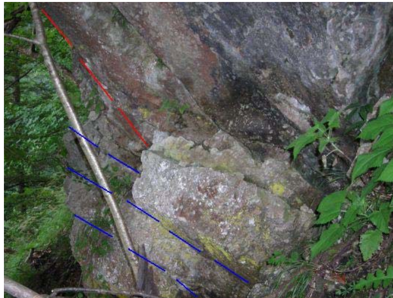
Abb. 25: Hauptdolomit-Felswand mit Bankung (blaue Linie) und Critical Layer (rote Linie)
