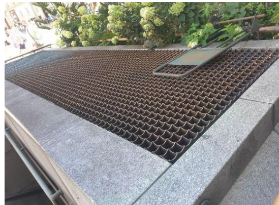
Fotografie 17: Stacheln auf Abluft (Quelle: Eigenes Foto)
