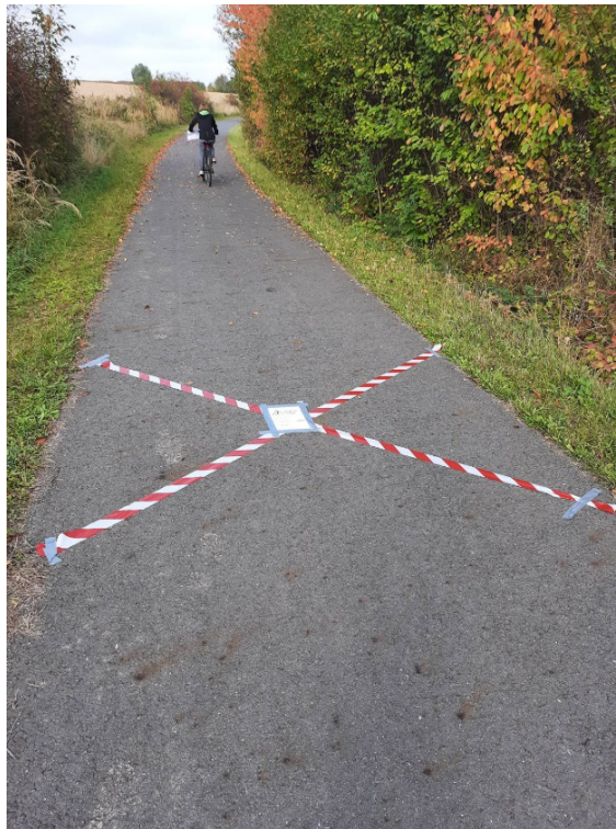
Abbildung 23: Warnhinweis auf der beflogenen Teilstecke (Aufnahme: Pöchersdorfer, P.)
