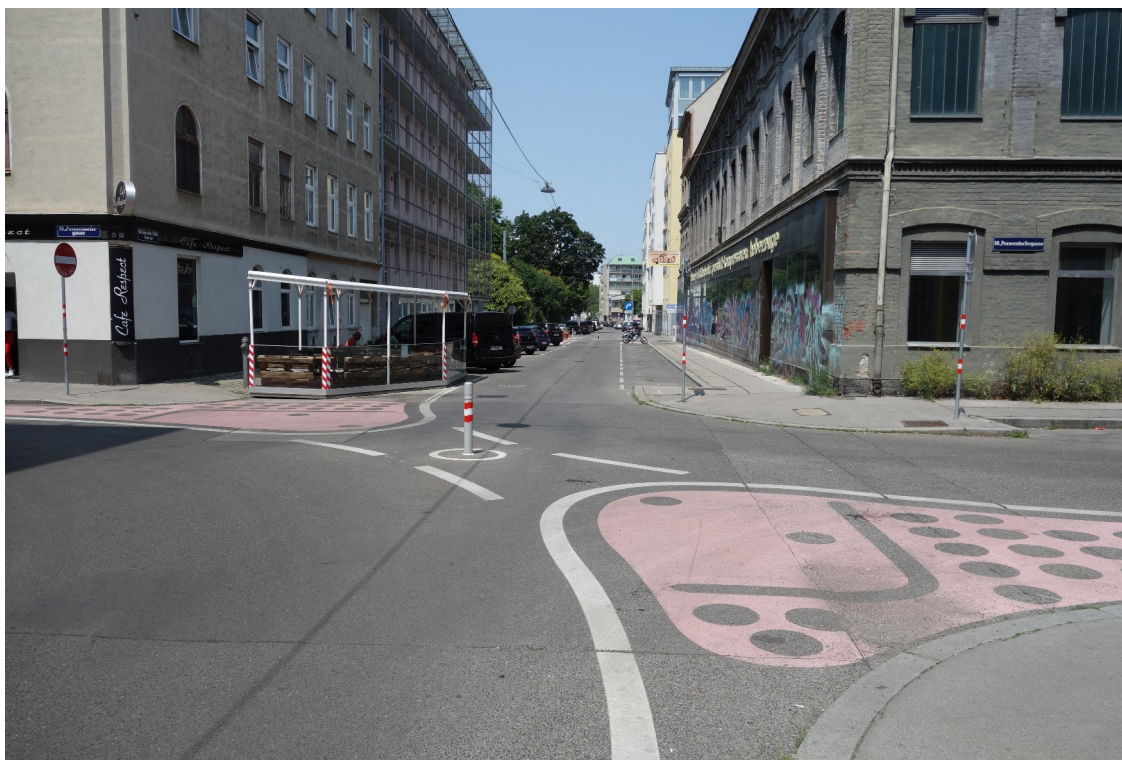
Abb. 16: Diagonalsperre mit Bodenmarkierungen an der Kreuzung
