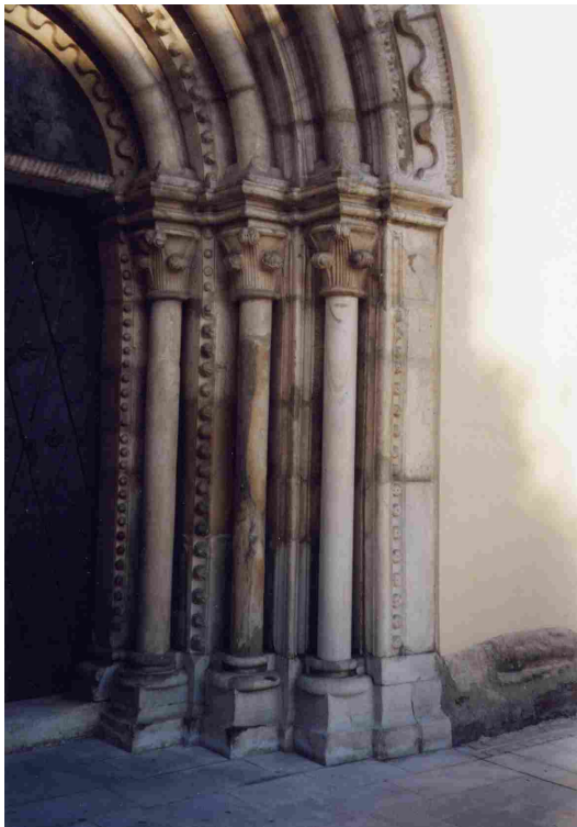
Abb. 100: Wolfsberg, Stadtpfarrkirche, Westportal, rechtes Gewände
