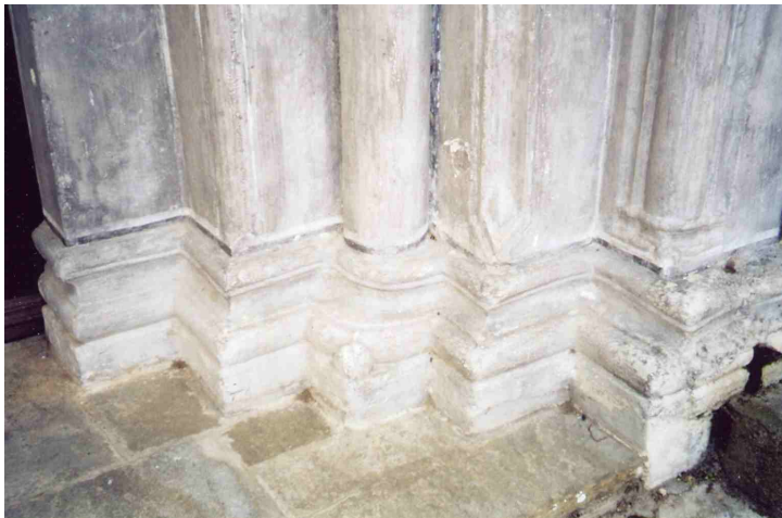
Abb. 5: St.Georgen am Längsee, Nordportal Basis
