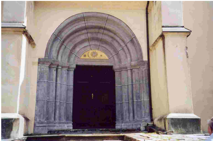
Abb. 1: St. Georgen am Längsee, Nordportal
