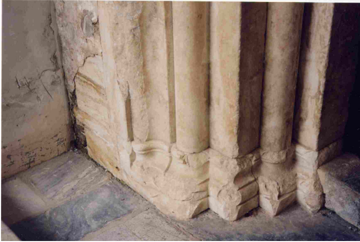
Abb. 60: St. Lambrecht, Südportal, linkes Gewände
