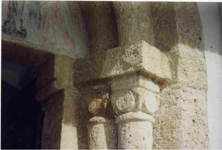
Abb. 107: Berg im Drautal, Pfarrkirche, Westportal, rechtes Gewände
