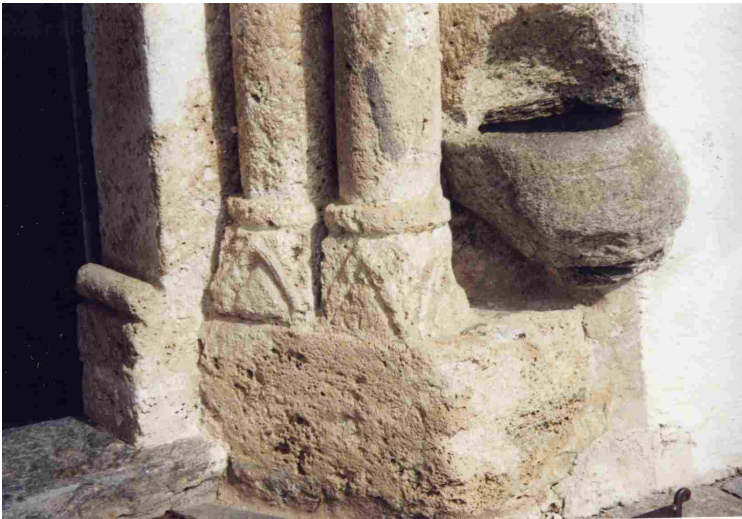
Abb. 108: Berg im Drautal, Pfarrkirche, Westportal, rechte Sockelzone
