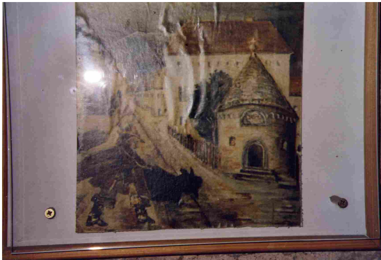
Abb. 85: Friesach, Petersberg, alte Ansicht des Karners
