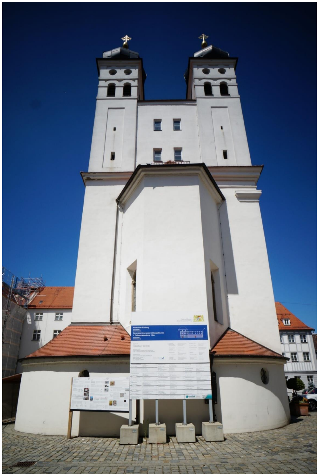
Abbildung 26: Günzburg, Hofkirche, Außenansicht, Chor und Türme
