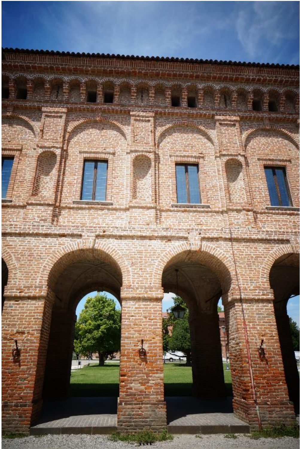
Abbildung 35: Sabbioneta, Galleria degli Antichi, Außenfassade, Detail
