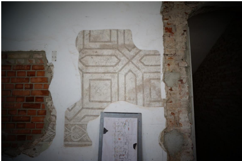
Abbildung 29: Günzburg, Residenz, Außenfassade, freigelegtes Fasadendetail, um 1580
