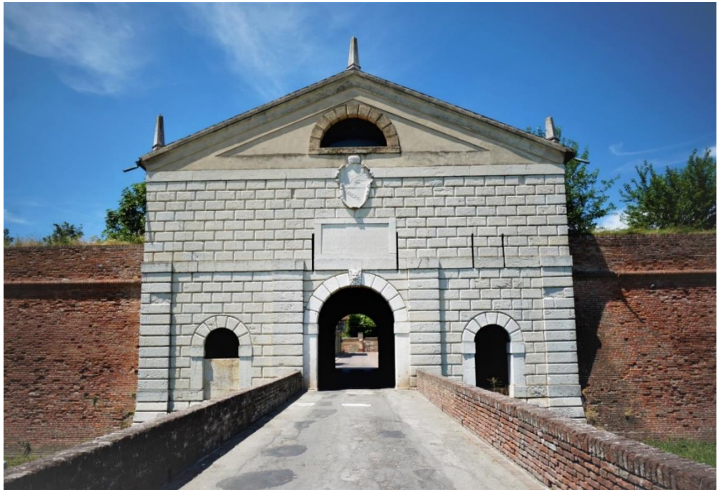
Abbildung 67: Sabbioneta, Kaisertor, Ansicht in Richtung Stadt
