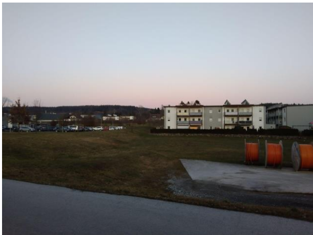
Foto 7: Wohngebäude St. Ruprecht a.d. Raab Quelle: Eigene Fotografie 2023
