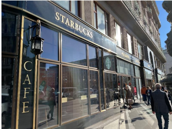
Abbildung 25: Einheitliche Fassaden Kärntnerstraße 51-53
