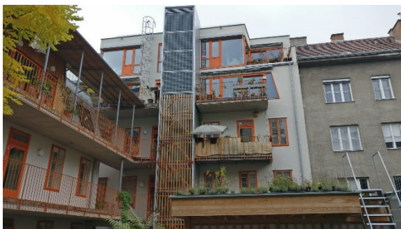
Aufnahme 12: Blick auf den Innenhof der Geblergasse 11, Hybridkollektoren auf zugebautem Aufzug, eigene Aufnahme vom 27.09.2022
