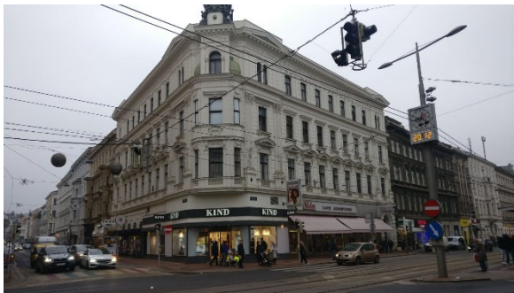
Aufnahme 7: Gründerzeitlicher Block bei Elterleinplatz Ecke Jörgerstraße/ Hernalser Hauptstraße und Kalvarienberggasse, eigene Aufnahme vom 20.12.2022
