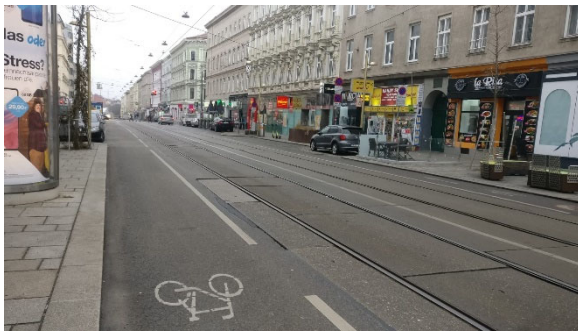
Aufnahme 3: Baulich nicht getrennter Radweg mit markierter Anlage entlang der Ottakringer Straße, eigene Aufnahme vom 20.12.2022
