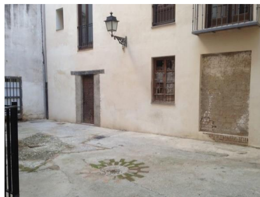
Figura 7: La entrada trasera oculta de la Casa Cuna donde supuestamente estaba el torno. En el suelo se puede ver el Pozo Airón de Granada
