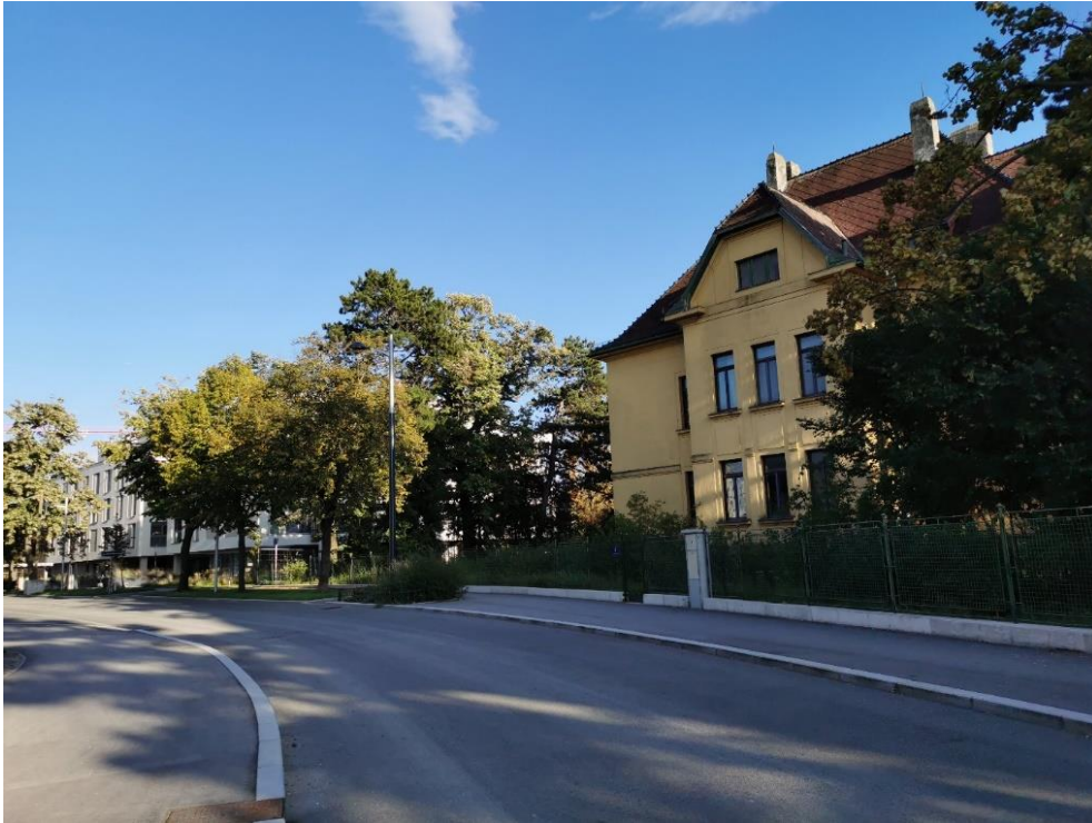
Abbildung 7: Blick von der Marischkapromenade auf ein historisches Bestandsgebäude und Baumbestand; Quelle: Eigene Aufnahme
