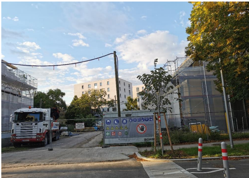
Abbildung 12: Renovierungsarbeiten an den Bestandsgebäuden; Quelle: Eigene Aufnahme
