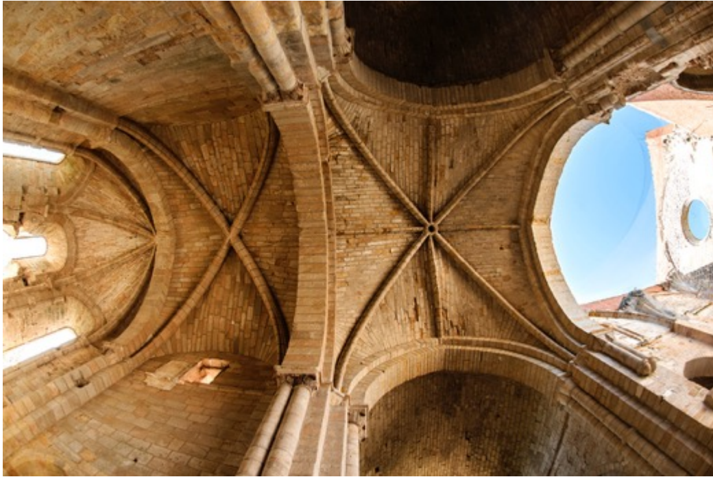
Abb. 86: Monsalud, Santa María, Kirche, Hauptapsis, Gewölbe, 13./16. Jhdt.
