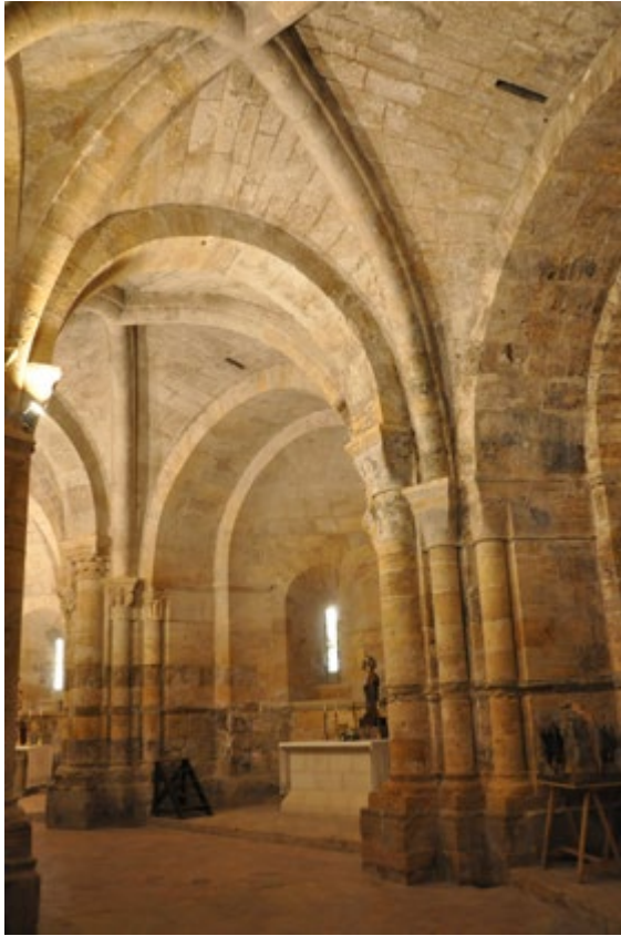
Abb. 42: Fitero, Santa María, Kirche, Umgang, Blick auf trapezförmigen Joche (Siehe auch Abb. 43) der Umgangskapellen, Ende 12./Anfang 13. Jhdt. (Aufnahme 2022).
