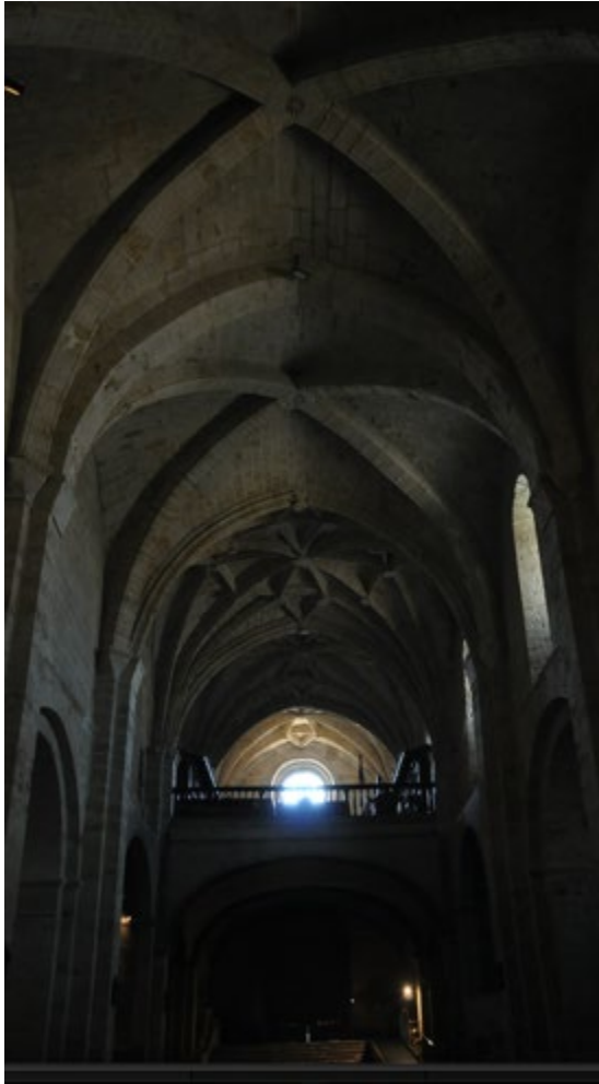
Abb. 45: Fitero, Santa María, Kirche, Langhaus mit Blick nach Westen, Sternengewölbe, 16. Jhdt. (Aufnahme 2022).
