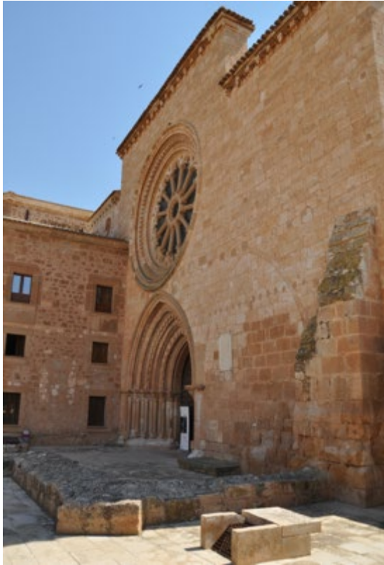
Abb. 64: Huerta, Santa María la Real, Kirche, Westfassade, Mauern des ehemaligen Narthex, 13./14. Jhdt. (Aufnahme 2022).
