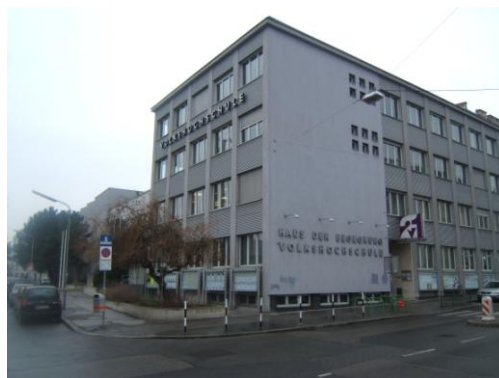
Abb. 13: Arbeiterheim Floridsdorf heute, Foto: Doris Warlitsch, 22. September 2008.
