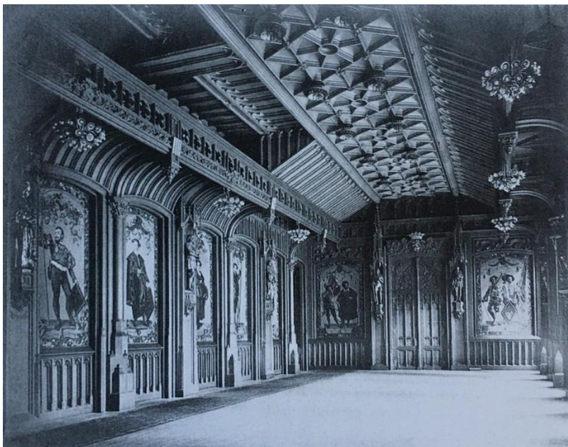
Abb. 76: Großer Saal nach Umbau des 19. Jahrhunderts, Brüsseler Rathaus.
