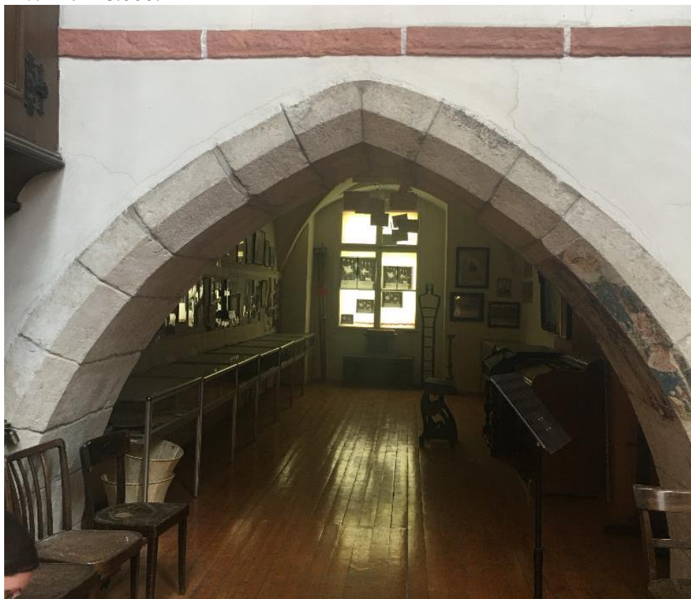
Abb. 44: Spitzbogen auf der Empore von St. Salvator in Wien, ehemaliger Emporenzugang, Fresko an der Laibung links, ca. 1373.
