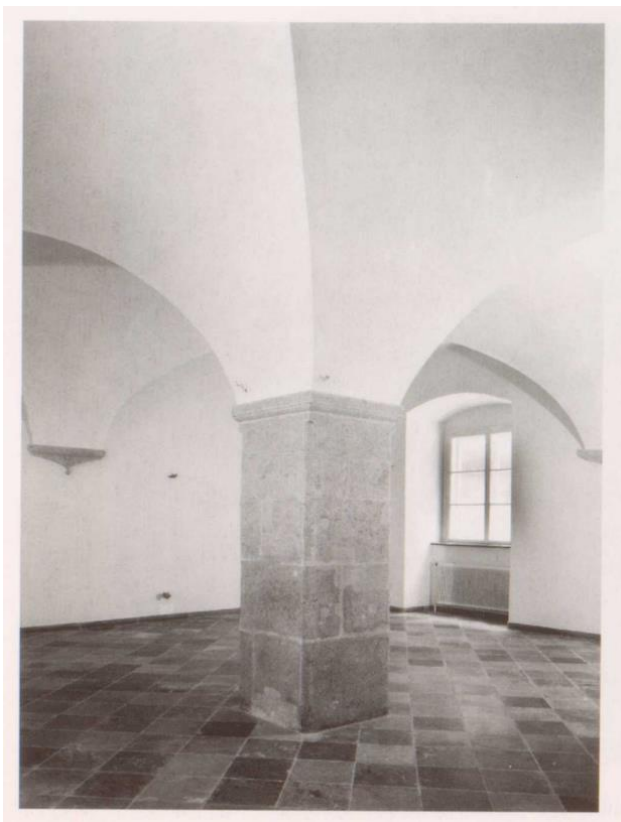
Abb. 14: Altes Rathaus, Bürgerstube, Einstützenraum mit Kreuzgratgewölbe, nach der Mitte des 16. Jahrhunderts.
