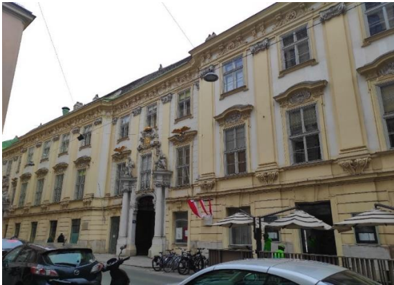
Abb. 1: Das alte Wiener Rathaus in der Gegenwart, Wipplingerstraße 6-8, 1010 Wien, barocke Schauffassade.
