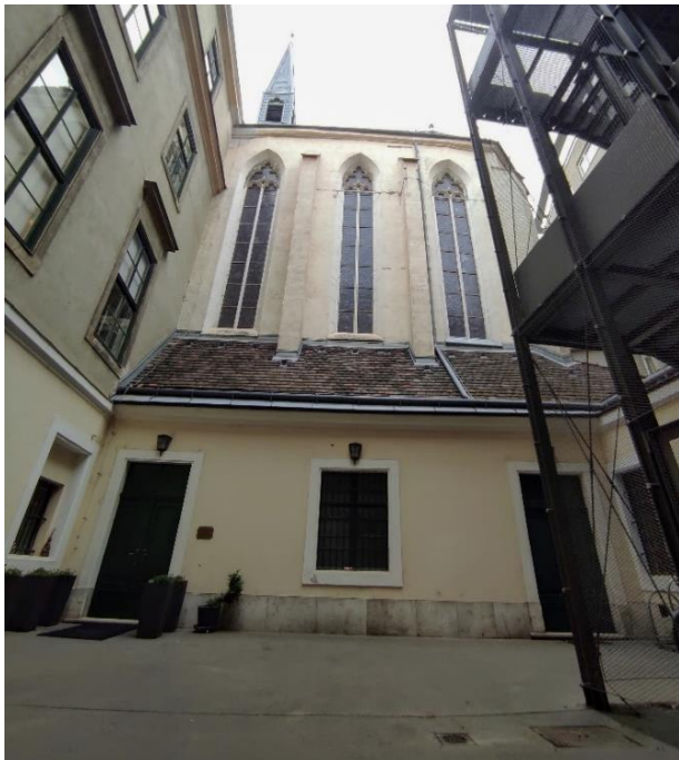
Abb. 11: St. Salvator, Südfassadenwand vom kleinen Salvatorhof gesehen.
