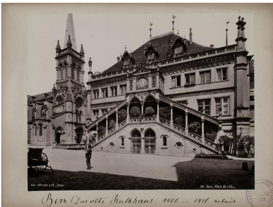
Abb. 70: Fassade des Berner Rathauses, 1406-16.
