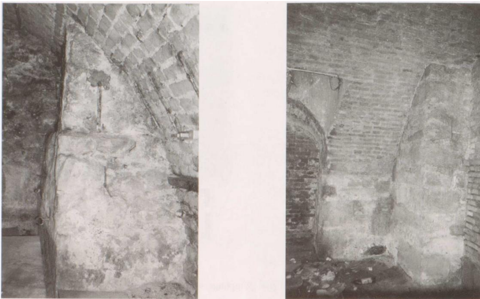
Abb. 53: Ehem. Haus des Efferlein, Pfeiler- oder Punktfundament, links 1. Kellergeschoß, rechts: 2. Kellergeschoß.
