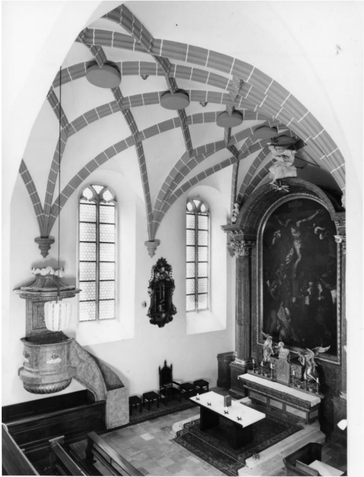
Abb. 8: Blick von der Empore auf die Nordkapelle von St. Salvator und deren Gewölbe.
