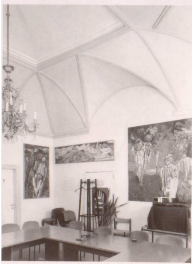
Abb. 15: Altes Rathaus, Nebenraum der ehemaligen Ratsstube.
