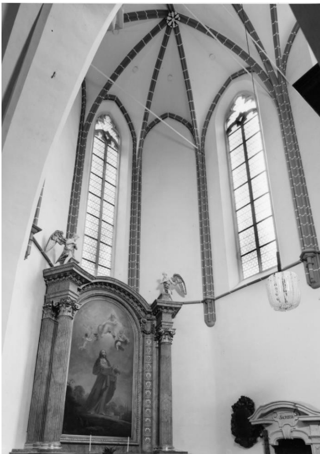
Abb. 7: Der 5/8-Chorschluss der Südkapelle von St. Salvator mit Blick auf das Gewölbe.
