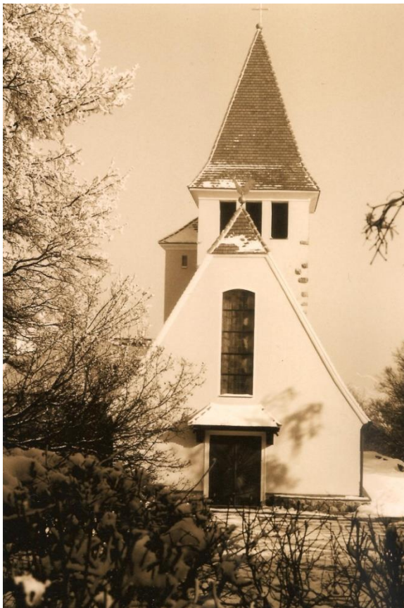
Abb. 28: Helene Koller-Buchwieser, Kirche Jungarbeiterdorf Hochleiten, Westansicht, 1953.
