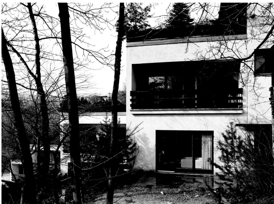
Abb. 126: Helene Koller-Buchwieser, Badgasse 2, Südansicht, Hinterbrühl, 1971.
