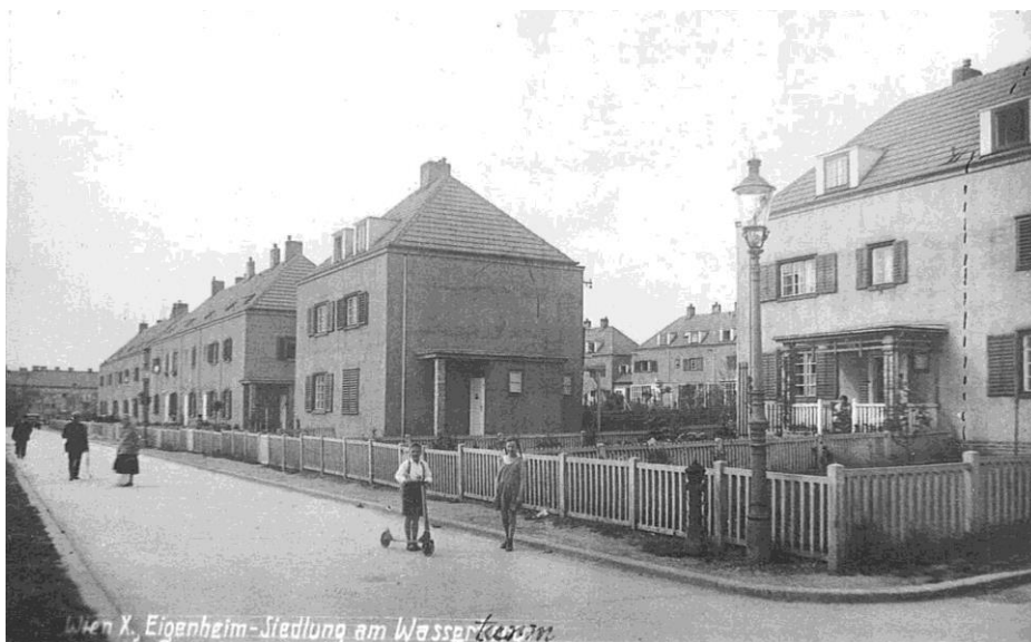
Abb. 153: Franz Schacherl/Franz Schuster, Siedlung „Am Wasserturm“, Raxstraße 31-111, Wien 10, 1923/24.
