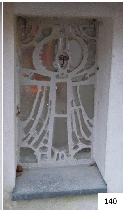
Abb. 138-140: Helene Koller-Buchwieser, Kröpfelsteigstraße 46/Schumachergasse 1, Detail Betonglasfenster Unterstand, Hinterbrühl, 1959.
