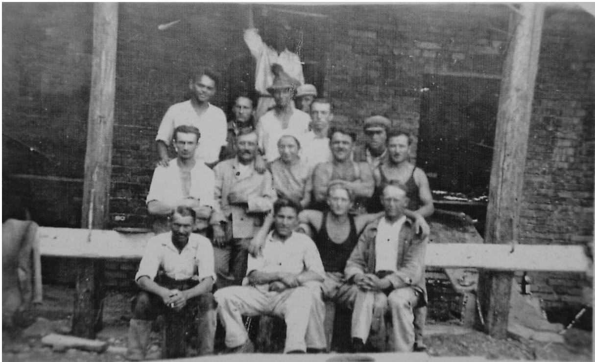
Abb. 7: Bauarbeiter*innen an der Baustelle des Karmelitinnenklosters, Dreherstraße, Wien 11 (Helene Koller-Buchwieser in der Mitte), 1932.
