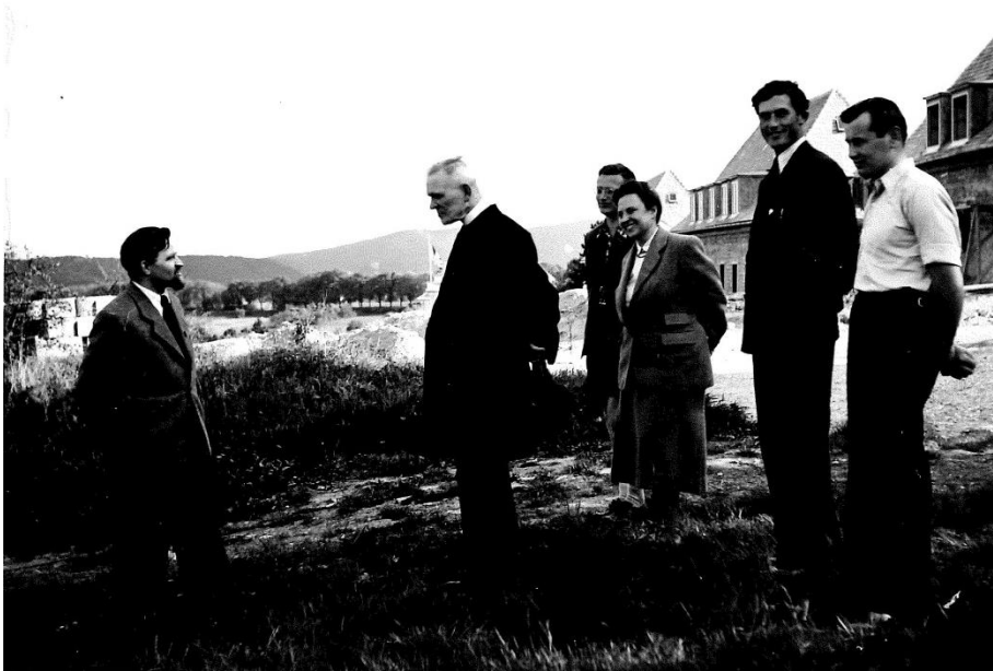
Abb. 99: Innitzer, Bruno Buchwieser und Helene Koller-Buchwieser vor den, sich im Bau befindenden, Wohnhäusern, Gießhübl, 1952.
