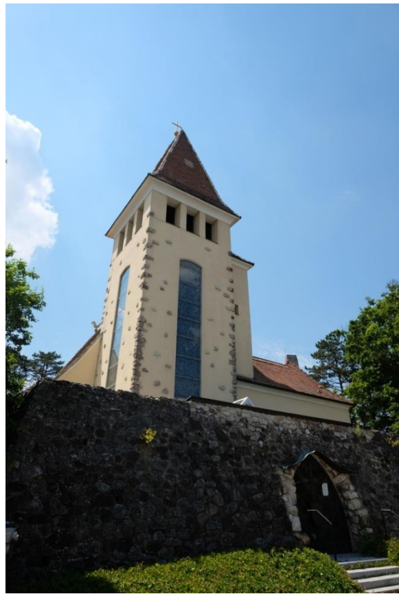
Abb. 29: Helene Koller-Buchwieser, Kirche Jungarbeiterdorf Hochleiten, Ostturm mit Eingang zur Unterkirche, 1953.
