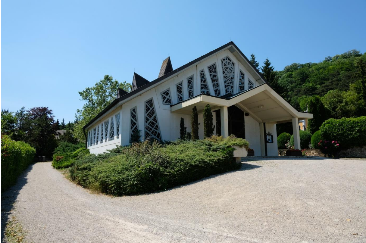
Abb. 25: Helene Koller-Buchwieser, Aufbahrungshalle Friedhof Hinterbrühl, 1977.
