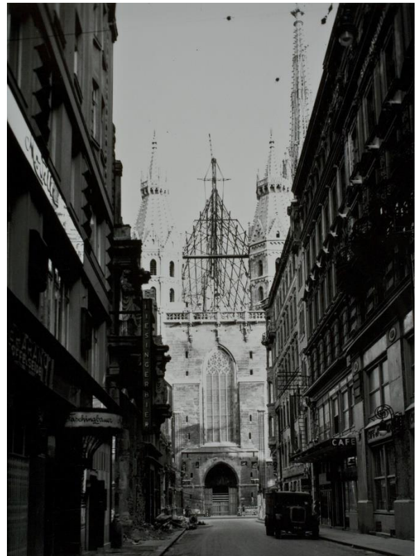
Abb. 12: St. Stephan, Errichtung des neuen Dachstuhls aus Stahl, Wien 1, 1945.
