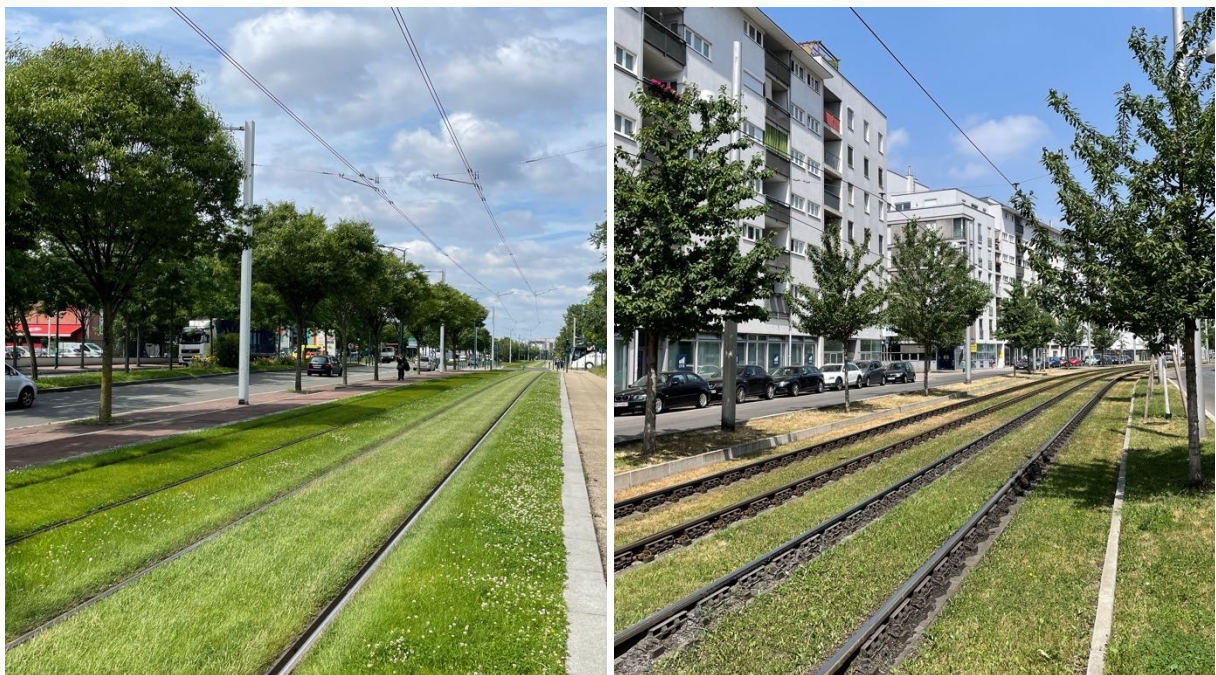
Abbildung 3-4: Vergleich von hochliegender und tiefliegender Vegetation im Gleisbereich
