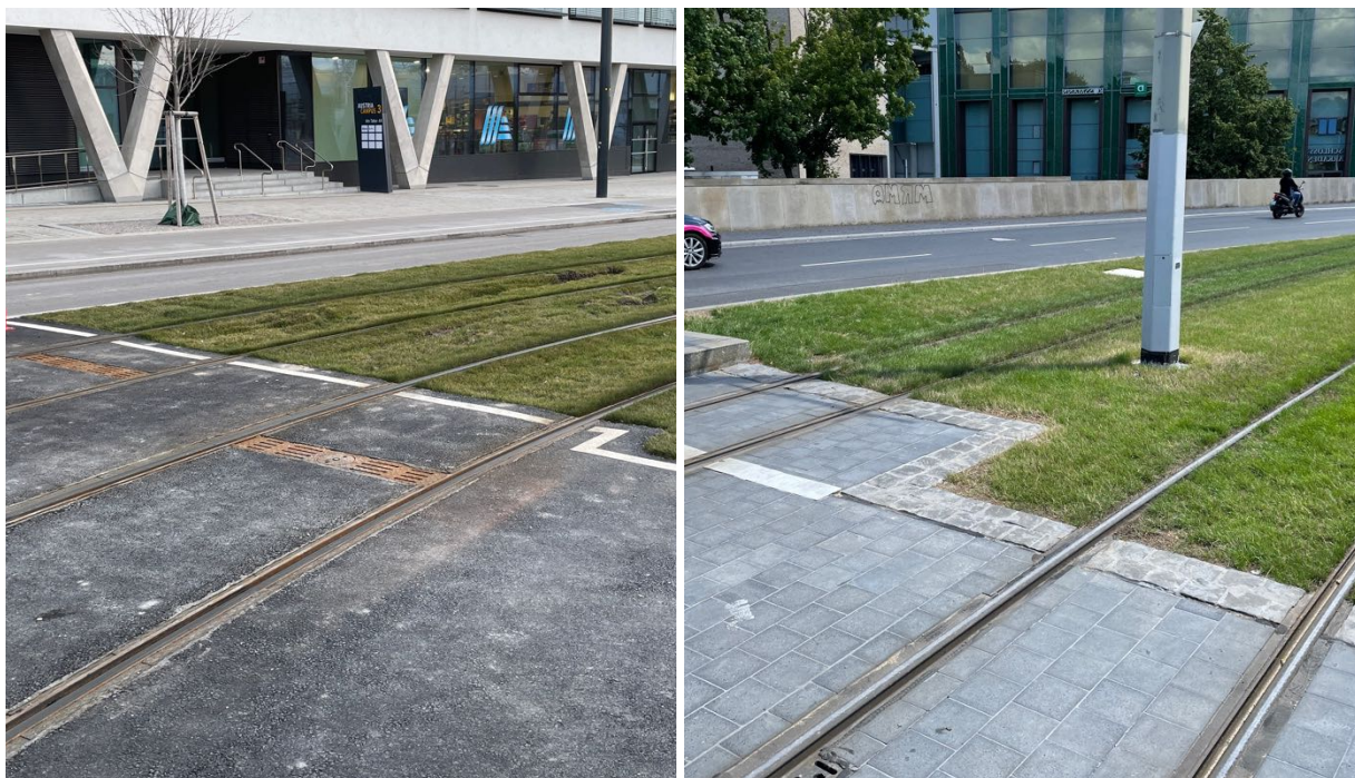
Abbildung 3-2: Übergänge der Oberflächen – Kostengünstige oder hochwertige Lösung
