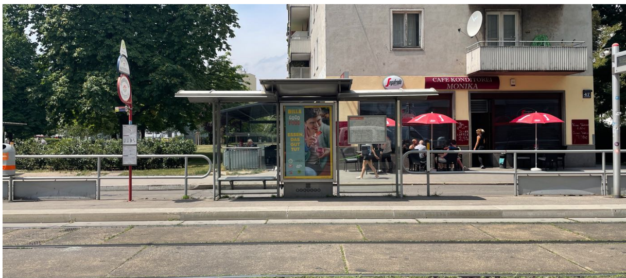
Abbildung 4-6: Links und rechts neben der Wartehalle kein Spritzschutz am Geländer
