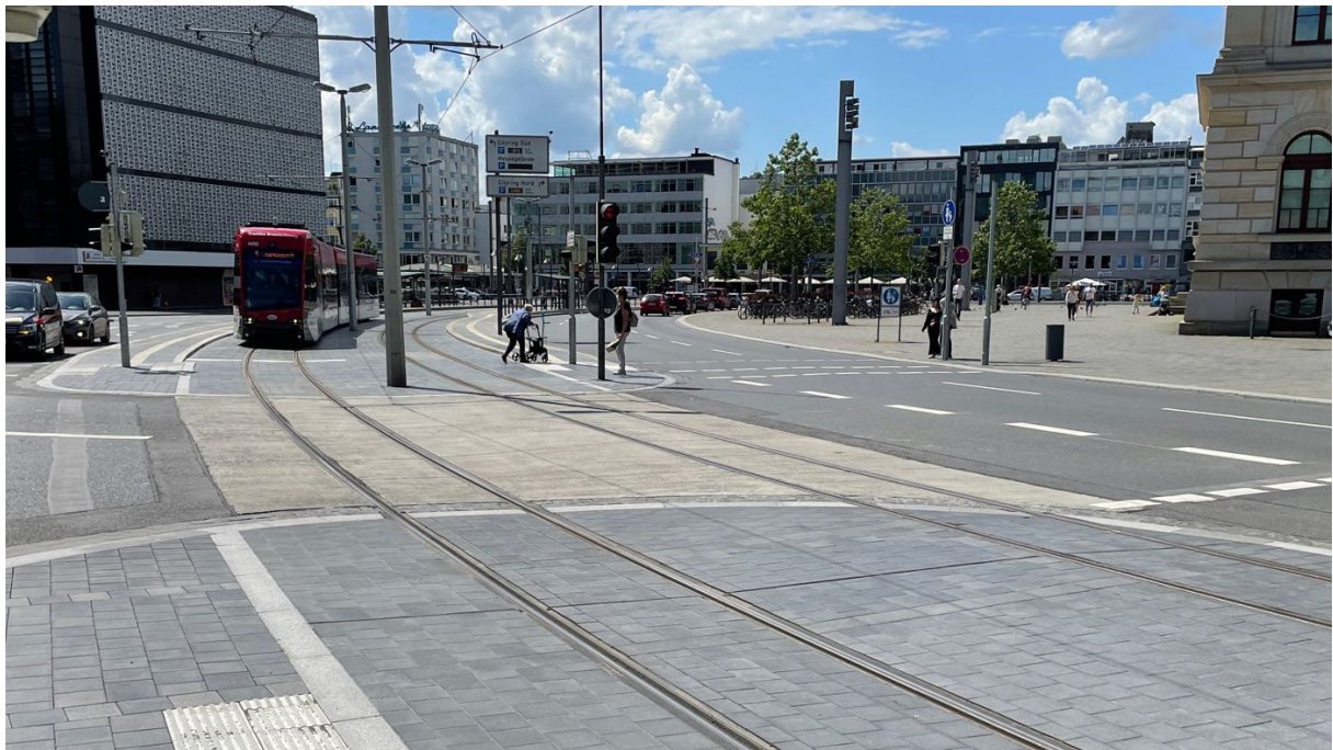
Abbildung 3-13: Beton an Abschnitten mit Querverkehr
