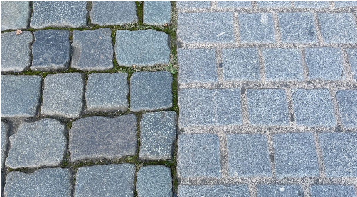
Abbildung 3-10: In Dresden trifft die ungebundene und gebundene Bauweise aufeinander
