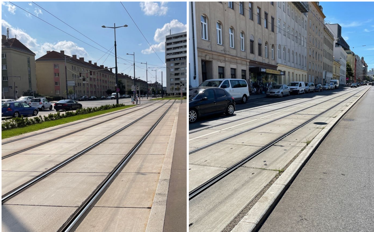
Abbildung 3-14: Trassen mit Großflächenplatten und Ortbeton in Wien
