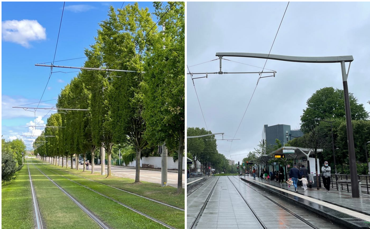
Abbildung 3-17: Der Fahrleitungsmast als integrierendes Element
