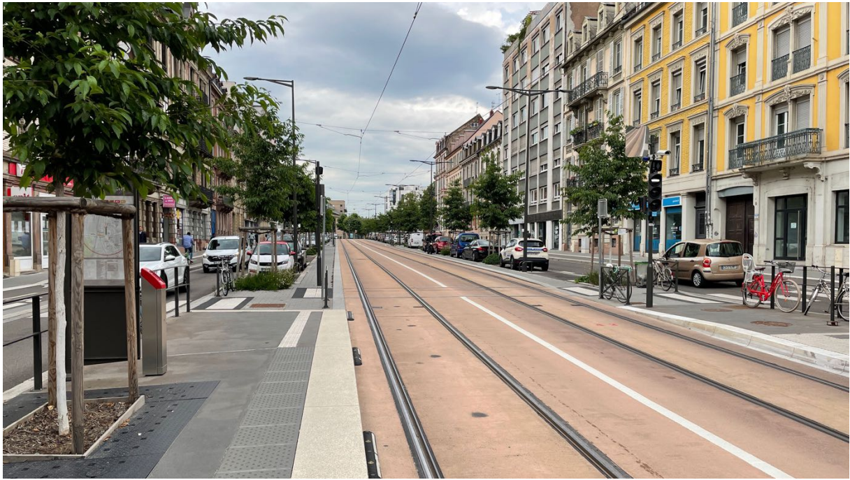
Abbildung 3-12: Gefärbter Asphalt strukturiert den Straßenraum in Straßburg
