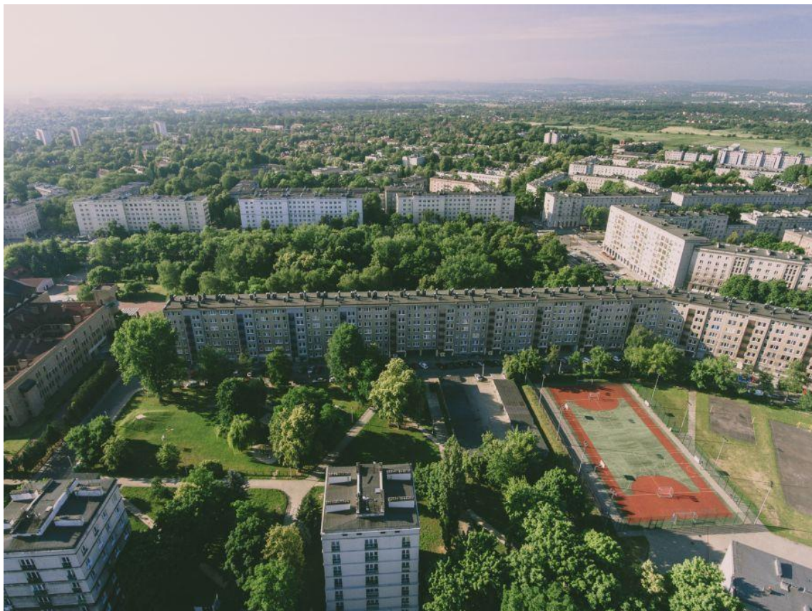
Abbildung 78 Foto 8: Links ein Beseirpark im Inneren der Wohnsiedlung. Oben der “Schwedische Block”, dahinter der Szwedzki [Schwedische] Park. Am unteren Bildrand Wohnblock Szklane domy [Glashäuser – Anspielung auf einen Romantitel]; zwei der vier identischen und ältesten auf dem Gelände. Rechts Fußballplatz der Volksschule Nr. 88. (Zarząd Zieleni Miejskiej w Krakowie 2016a).
