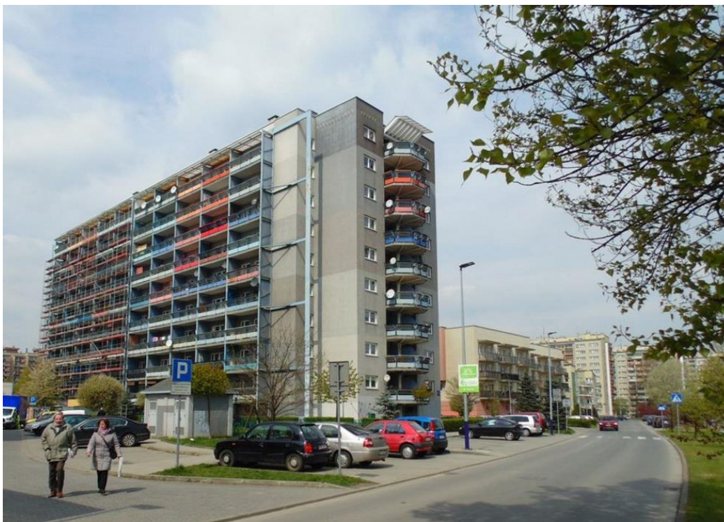
Abbildung 99 Foto 26: Postmoderne Gebäude, im Hintergrund mit Glaselementen, direkt an der Straße; Foto: Damian Daraz (investmap 2017).
