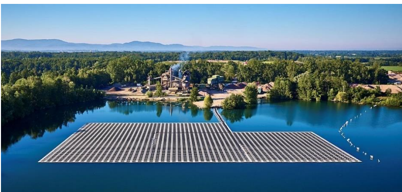
Abb. 10: Floating PV-Anlage auf einem Baggersee (Quelle: Greenhouse Media 2020)
