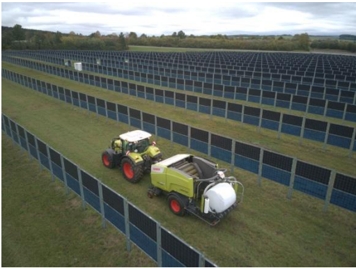
Abb. 8: Horizontale/Bifaziale Agri-PV-Anlage (Quelle: EMMERICH 2021)
