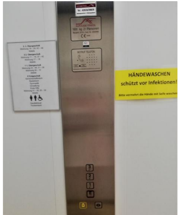
Abb. 39: Liftbereich mit tief platzierten Tasten auf Griffhöhe, Blindenschrift, (Foto: Simonis, 2021)
