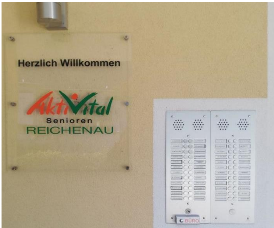
Abb. 22 Sprechanlage vor der Eingangstüre, die Klingel für das Büro ist ganz unten in Griffhöhe (Foto: Simonis, 2021)
