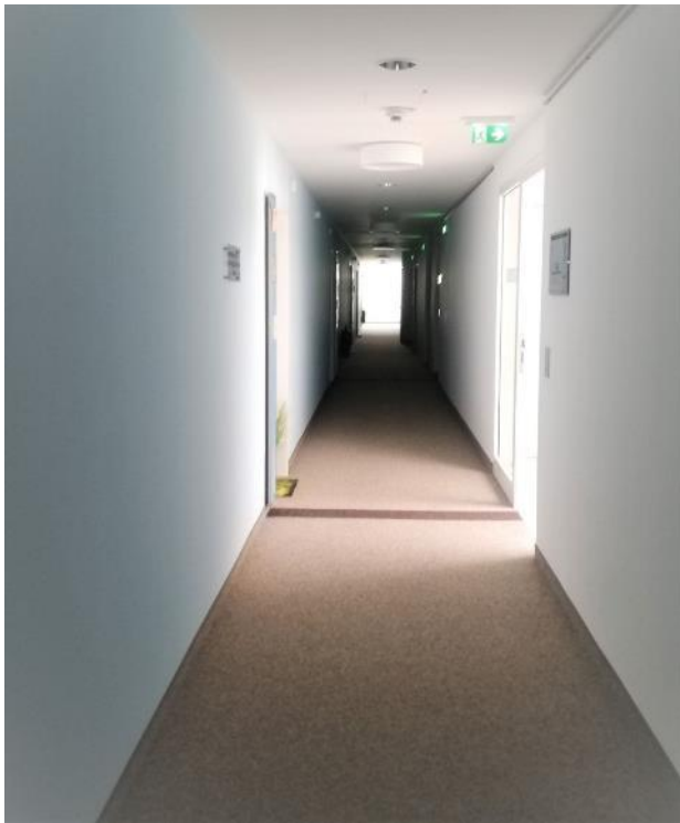
Abb. 38: Schwellenloser Flur, farblich abgehoben von den anderen Etagen, (Foto: Simonis, 2021)
