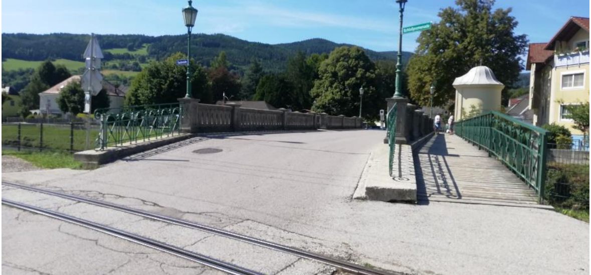
Abb. 48: Blick auf die Zufahrt zur Abt-Balthasar-Straße von der Hauptstraße aus, (Foto: Simonis 2021)
