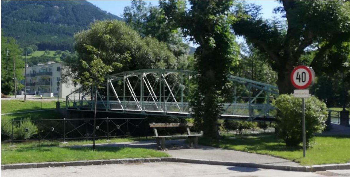
Abb. 50: Blick auf den Gehweg über die Esplanade von der Hauptstraße aus, Im Hintergrund ist das AktiVital Wohngebäude zu sehen, (Foto: Simonis, 2021)
