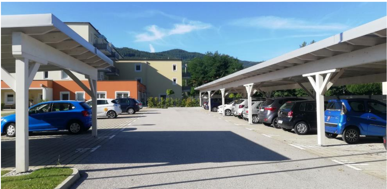
Abb. 15: Parkplatz mit Carports und E-Ladestation (Foto: Simonis, 2021)
