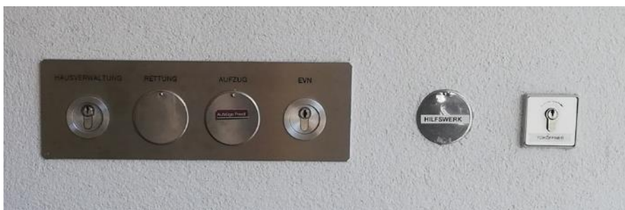
Abb. 23: Rechts neben der Eingangstüre Zugangsmöglichkeiten nach Zuständigkeit - Aufzählung von links nach rechts: Hausverwaltung, Rettung, Lift, EVN, Hilfswerk, (Foto: Simonis, 2021)
