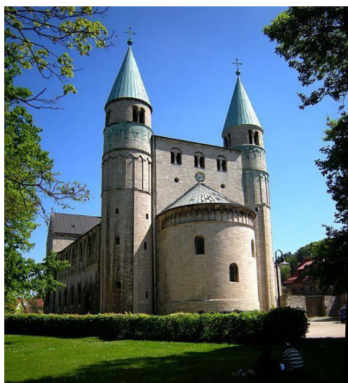
Abb. 58: Gernrode, St. Cyriakus Ansicht von Südosten
