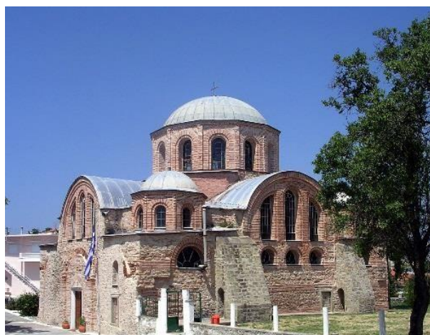
Abb.164: Ferres, Panagia Kosmosotira: Strebebögen und Spuren eines inzwischen (wieder?) abgebrochenen Narthex
