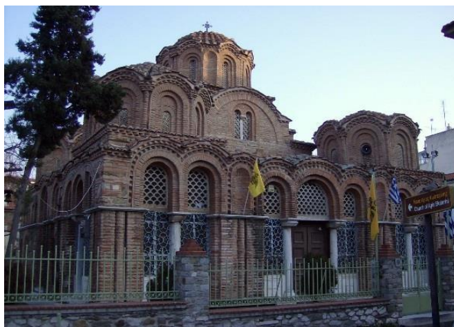
Abb.166: Thessaloniki, Panagia Chalkeon; auch statisch irrelevante Kuppeln ersparen den Dachstuhl.
