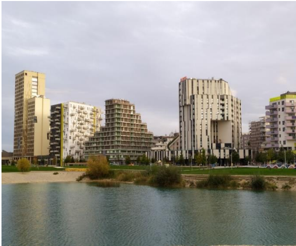
Abbildung 36 Der Bürostandort Seestadt - Aspern; Quelle: eigene Aufnahme vom 7.10.2020
