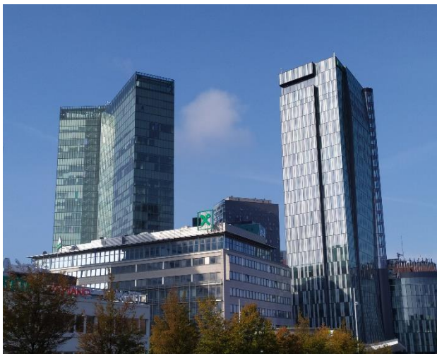
Abbildung 28 WienerbergCity; Nordostansicht; Quelle: Eigene Aufnahme vom 22.10.2020; weitere Aufnahmen zum Bürostandort WienerbergCity siehe Abbildung 56 im Anhang
