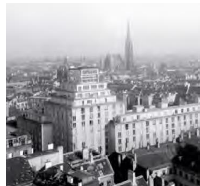
Abbildung 19 Das erste Wiener Hochhaus in der Herrengasse der Architekten Theiß und Jaksch; Quelle: MA 18 2017:45
