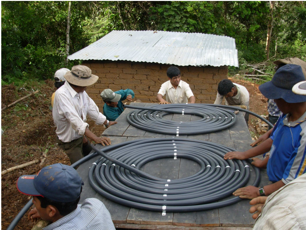
Abbildung 6: Montage von zwei in Serie geschalteten Caracoles in Apana (Privatfoto)
