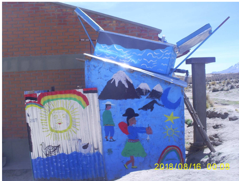
Abbildung 15: Kollektor in Jesús de Yunguyo mit geöffneter Nachtabdeckung
