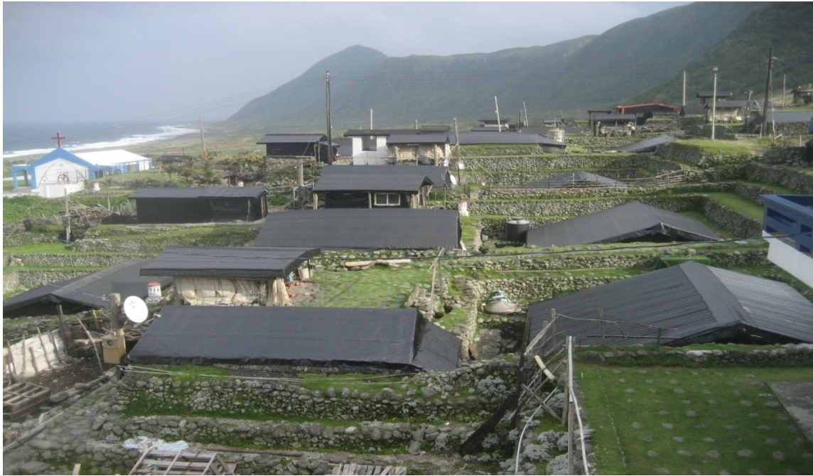
Abb. 6: Blick auf die traditionellen Häuser in Yeyin
